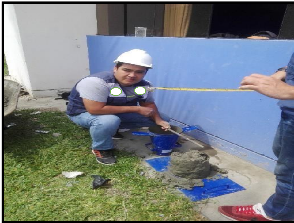
FOTO 17- SLUMP DEL CONCRETO
