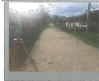
Levantamiento línea de conducción
