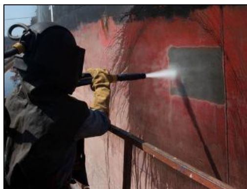
Calidad de acabado de estructuras metálicas con 8 bar.
