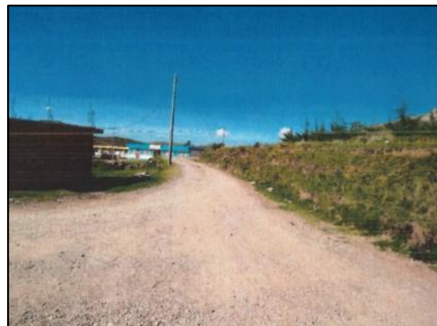
Figura 16. Fin de tramo Km 14+000, Perka.
