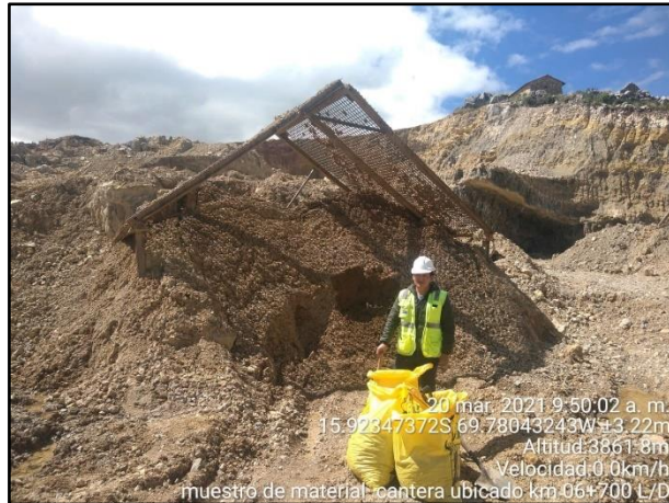
Figura 17. Ubicación de la cantera en situ M-01.
