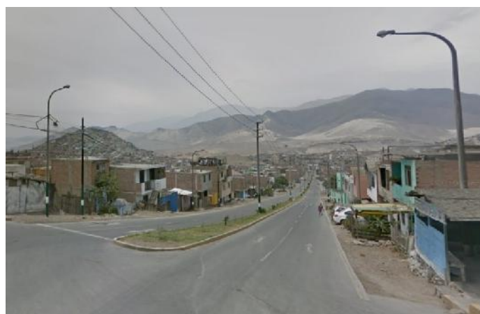
Figura 25. Avenidas con Alumbrado Público
