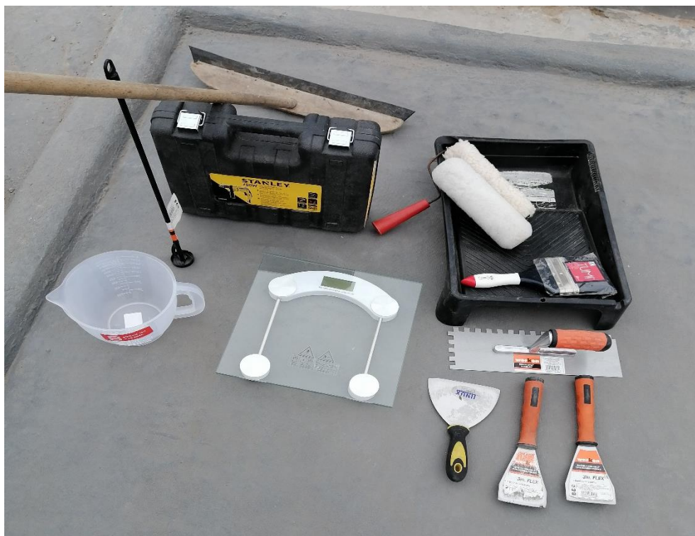
Foto N° 12: Vista de los instrumentos que se utilizarán en el proceso de impermeabilización.
