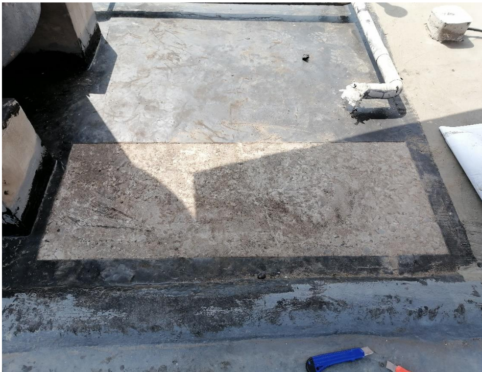
Foto N° 50: Vista del área que se extrajo la muestra de poliuretano líquido.
