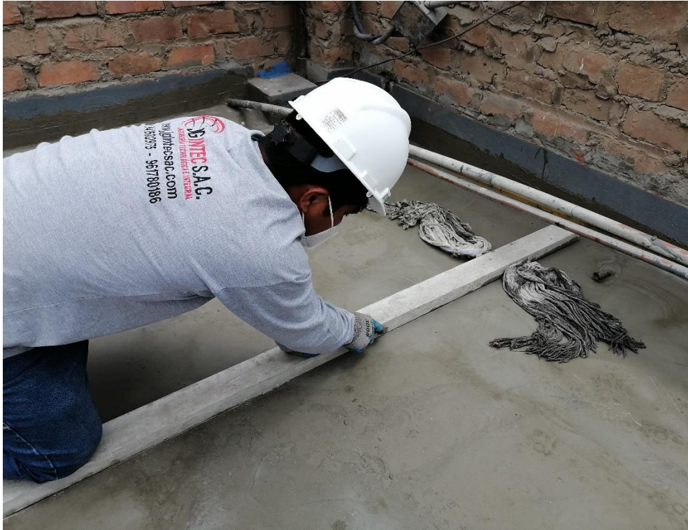
Foto N° 45: Se inició con el corte del área a extraer para llevar al laboratorio con ayuda de una cutter.
