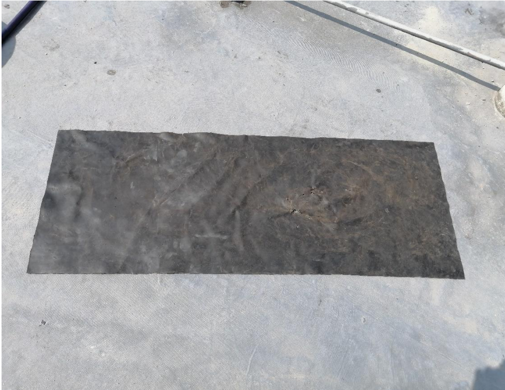
Foto N° 51: La muestra extraída, la cual se llevará al laboratorio para los respectivos ensayos.
