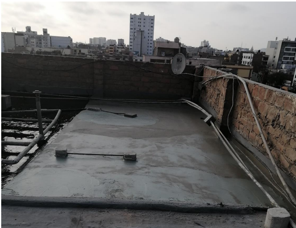
Foto N° 40: Vista general del acabado de la impermeabilización de la segunda capa de la malla de fibra de vidrio Mapenet 150 con el mortero cementoso mapelastíc Smart.
