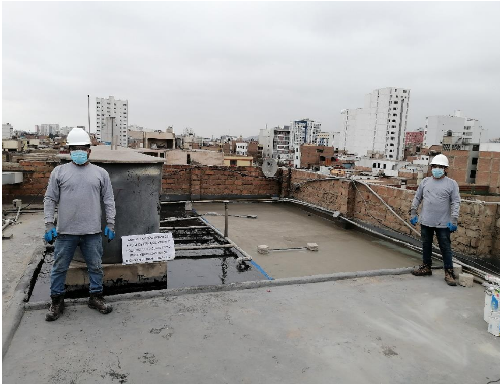
Foto N° 27: Vista general del acabado de la primera capa de cada uno de los impermeabilizantes, el poliuretano líquido y la malla de fibra de vidrio en conjunto con el mapelastic Smart.
