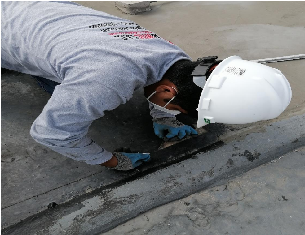
Foto N° 49: De igual manera con ayuda de una cutter se comenzó a extraer la muestra del poliuretano líquido.
