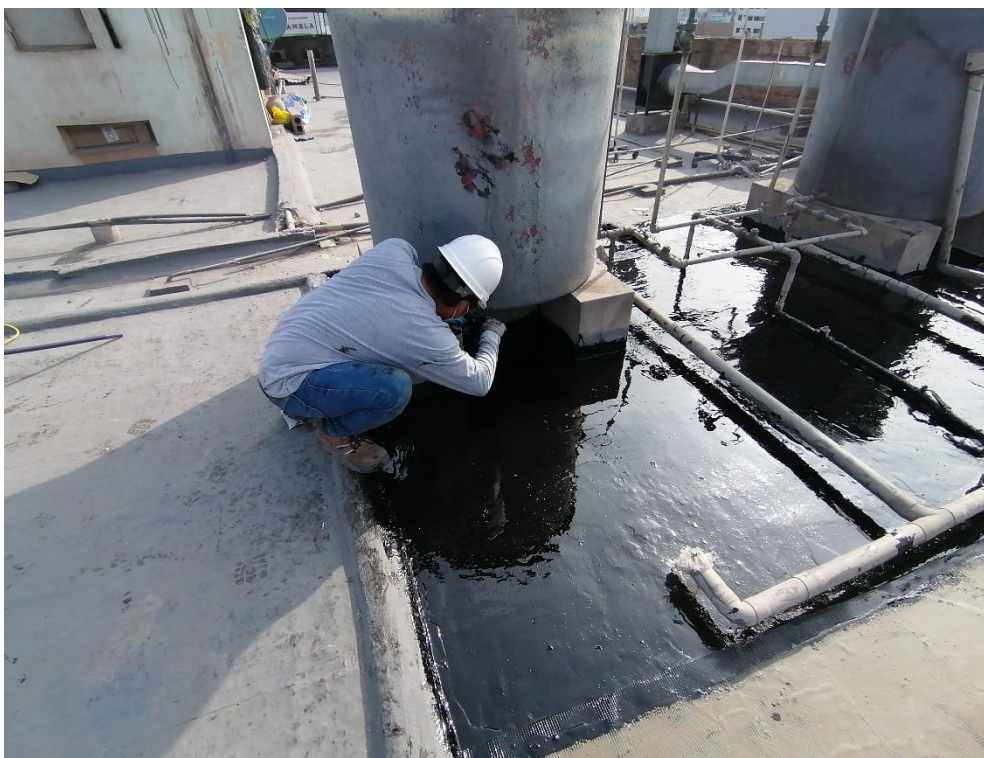
Foto N° 32: Vista de la aplicación de la segunda capa del poliuretano líquido Hyperdesmo en zonas no accesible para el rodillo.
