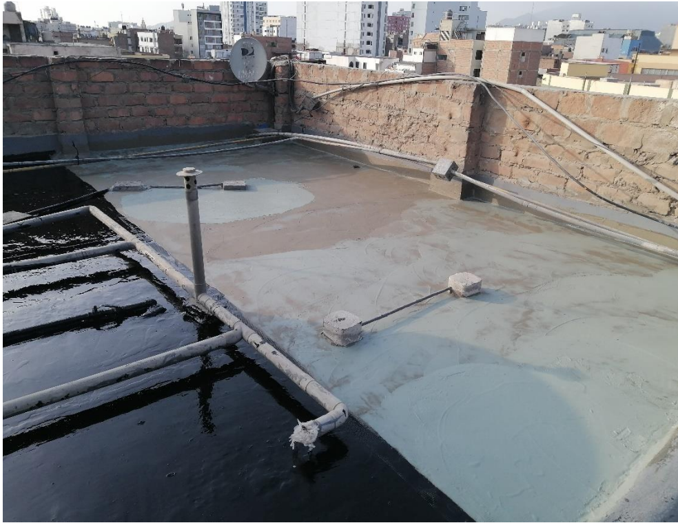
Foto N° 39: Vista general del acabado de la impermeabilización de la segunda capa de la malla de fibra de vidrio Mapenet 150 con el mortero cementoso mapelastíc Smart.
