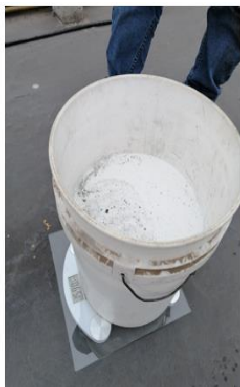
Foto N° 20: Se empezó el proceso de preparado del mapelastic Smart pack (A+B) colocando sus dos componentes en un recipiente y pesándolo para obtener el rendimiento deseado.
