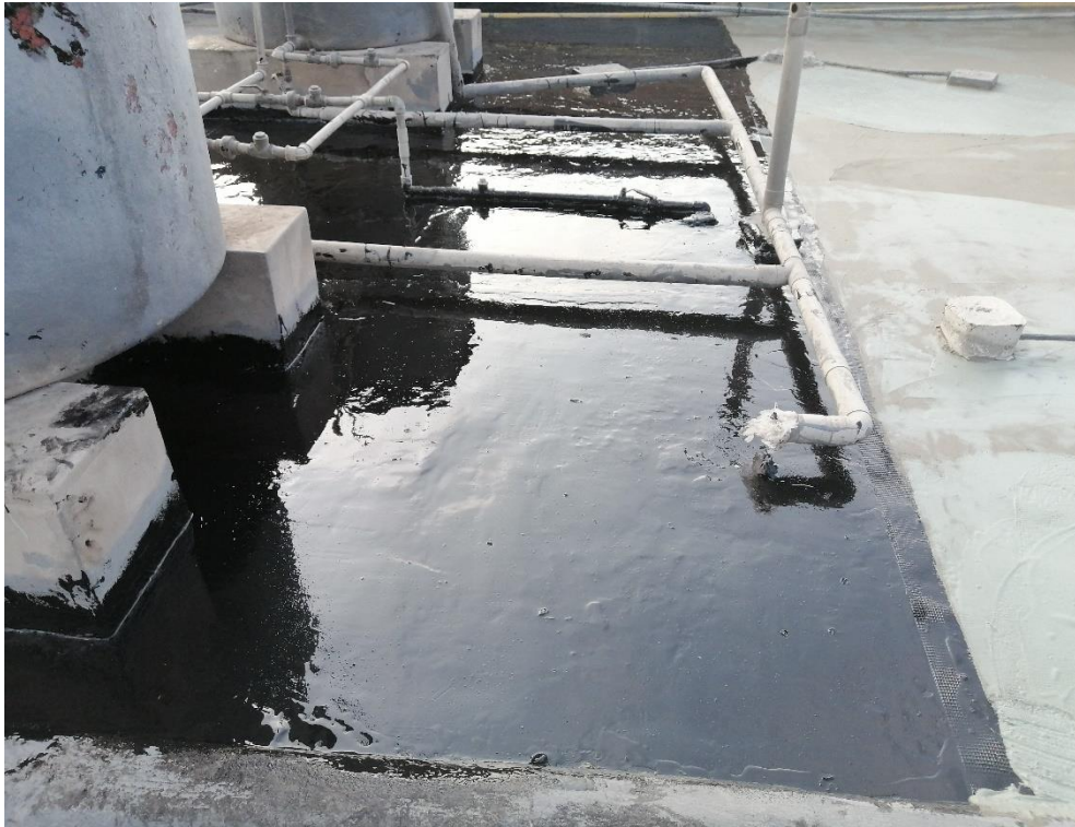
Foto N° 35: Vista específica del acabado de la impermeabilización de la segunda capa del poliuretano líquido Hyperdesmo.
