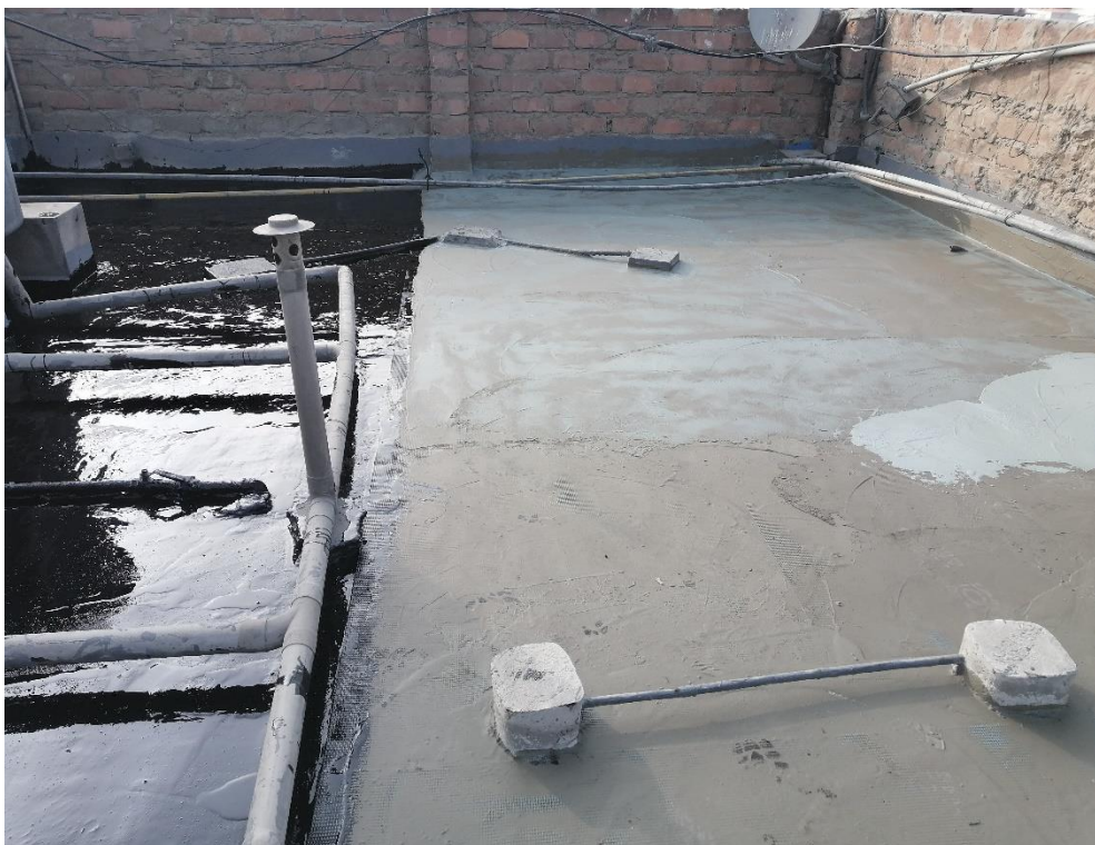
Foto N° 38: Vista específica de la impermeabilización de la segunda capa de la malla de fibra de vidrio Mapenet 150 con el mortero cementoso mapelastic Smart.
