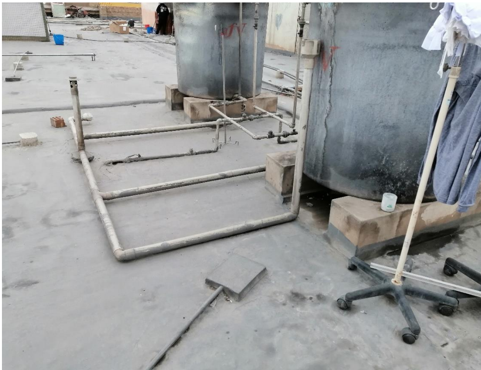
Foto N° 4: Vista del área designada por el hospital para la impermeabilización con la malla de fibra de vidrio y el poliuretano líquido.
