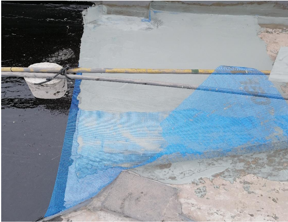
Foto N° 25: Se aplicó la primera capa de mapelastic Smart y encima de ella se colocó la malla de fibra de vidrio.
