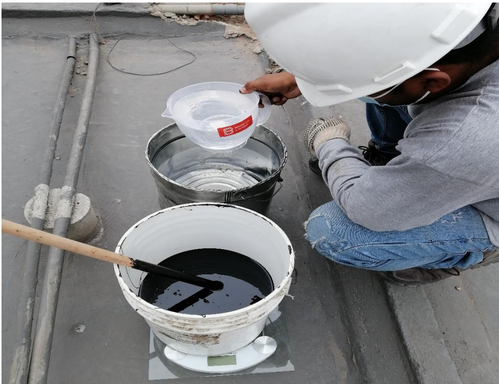
Foto N° 16: Al recipiente con el componente B se le adiciono el componente A y peso para obtener el rendimiento deseado.
