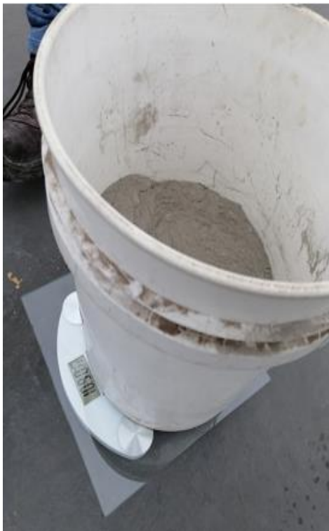
Foto N° 20: Se empezó el proceso de preparado del mapelastic Smart pack (A+B) colocando sus dos componentes en un recipiente y pesándolo para obtener el rendimiento deseado.
