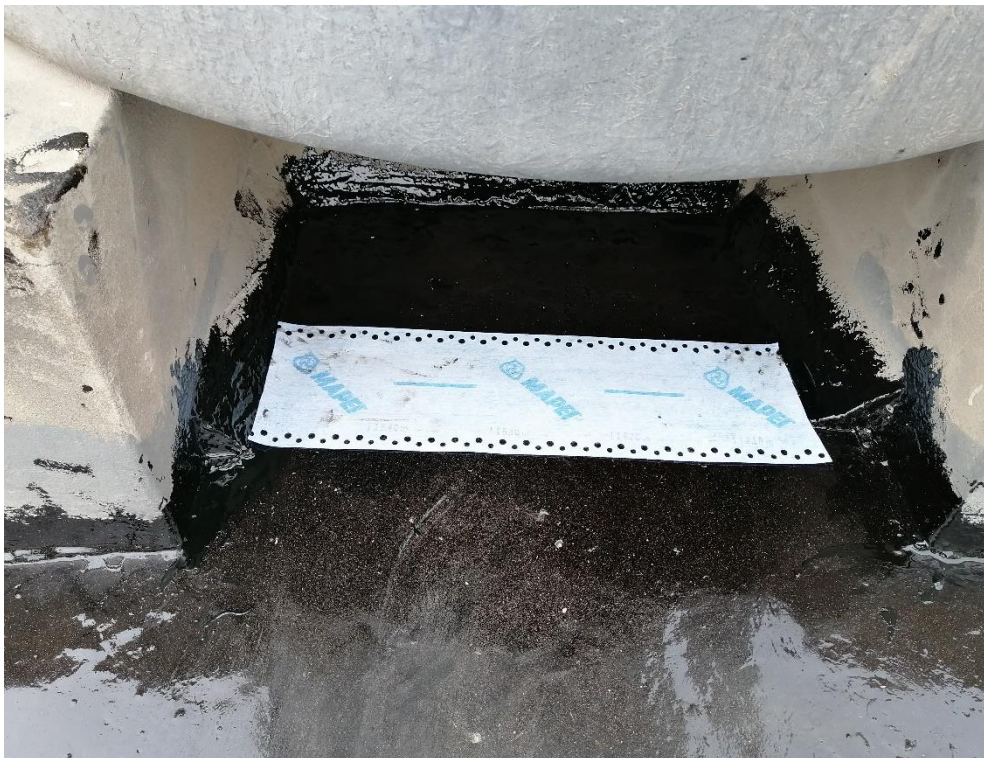
Foto N° 30: Se colocó a manera de refuerzo la cinta mapeband easy en las zonas donde se observó una fisuración en la losa aligerada.
