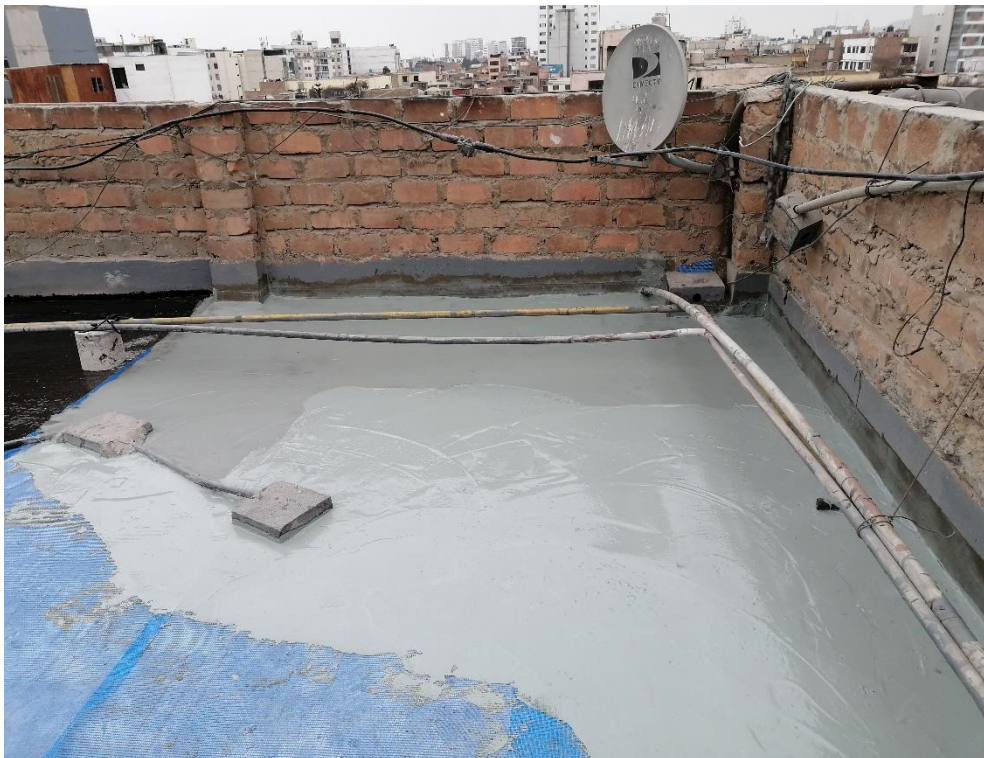
Foto N° 26: Se aplicó la primera capa de mapelastic Smart y encima de ella se colocó la malla de fibra de vidrio.
