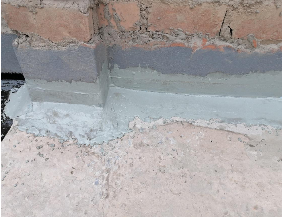
Foto N° 23: Se aplicó la primera capa de mezcla de mapelastic Smart en las zonas donde se colocó el mapeband easy.
