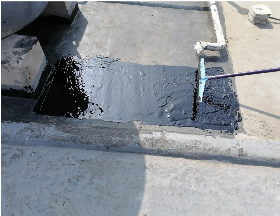
Foto N° 52: Se finalizó con el sellado de la última muestra extraída.
