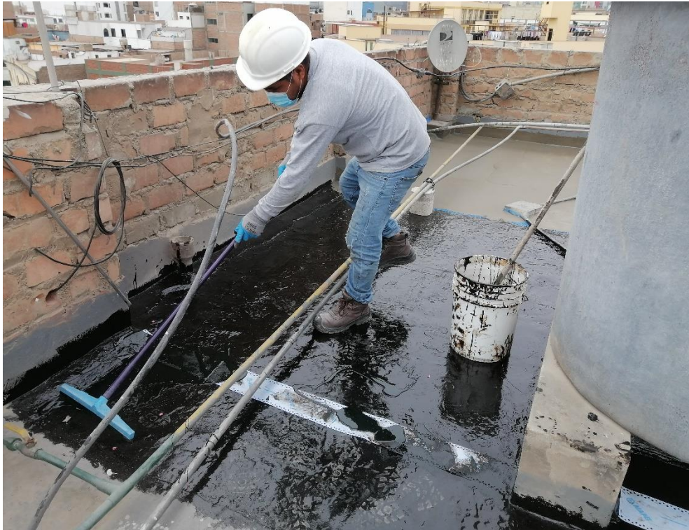
Foto N° 31: Vista de la impermeabilización de la segunda capa del poliuretano líquido Hyperdesmo.
