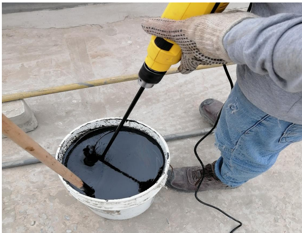
Foto N° 18: Se procedió a mezclar los componentes A y B con un batidor para obtener una mezcla uniforme y grumos.
