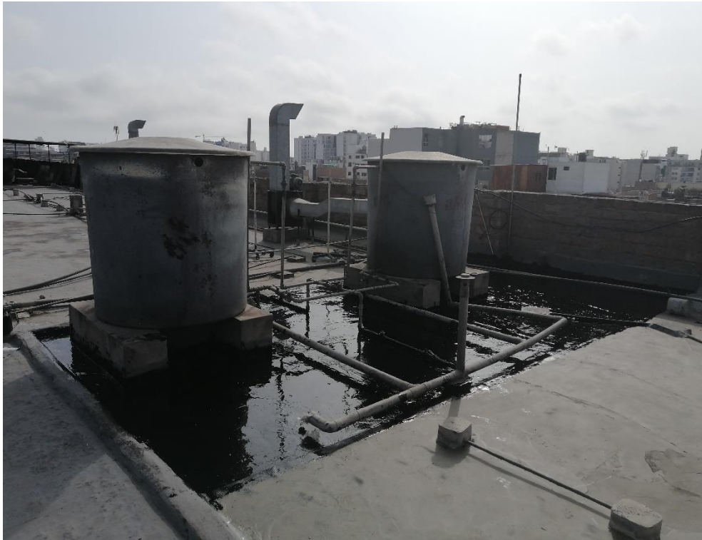
Foto N° 33: Vista general del acabado de la impermeabilización de la segunda capa del poliuretano líquido Hyperdesmo.
