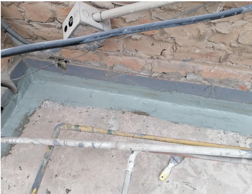
Foto N° 24: Se aplicó la primera capa de mezcla de mapelastic Smart en las zonas donde se colocó el mapeband easy.
