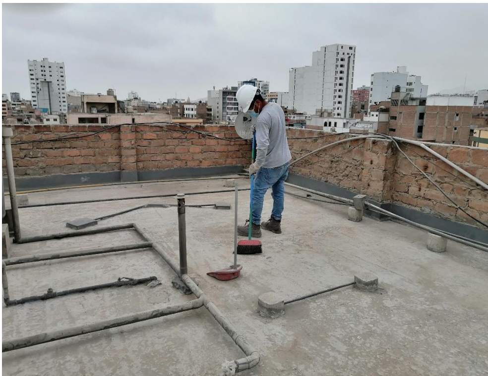
Foto N° 8: Se inició la limpieza respectiva del área designada a impermeabilizar.
