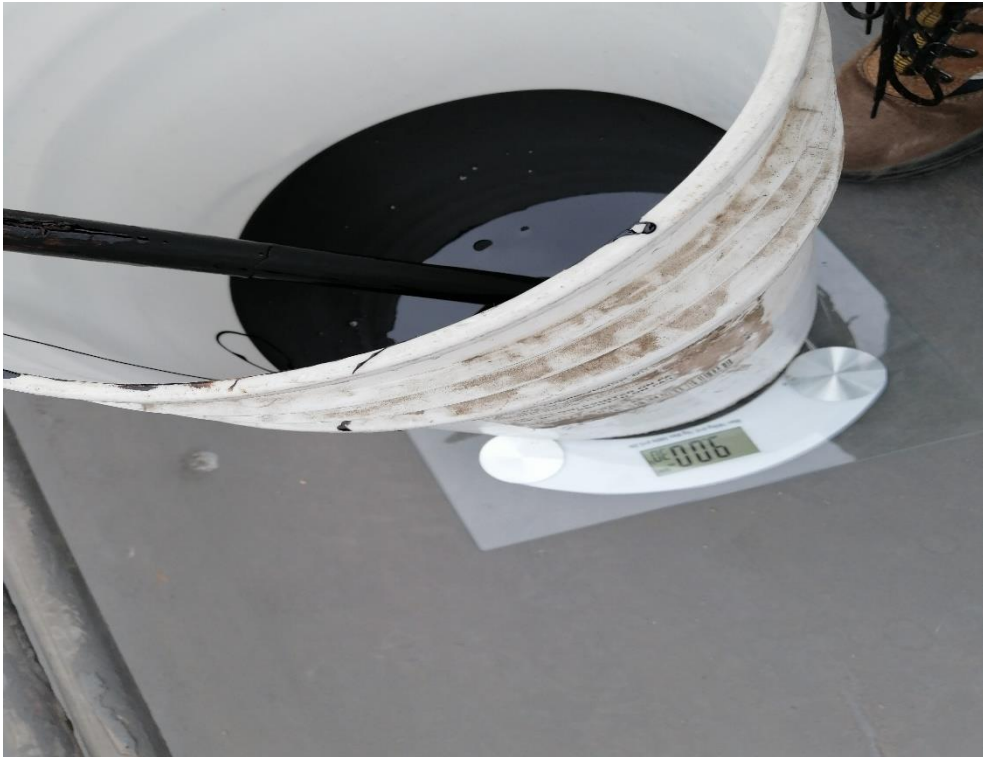
Foto N° 15: Se empezó el proceso de preparado del poliuretano líquido colocando en un recipiente el componente B y pesándolo para obtener el rendimiento deseado.
