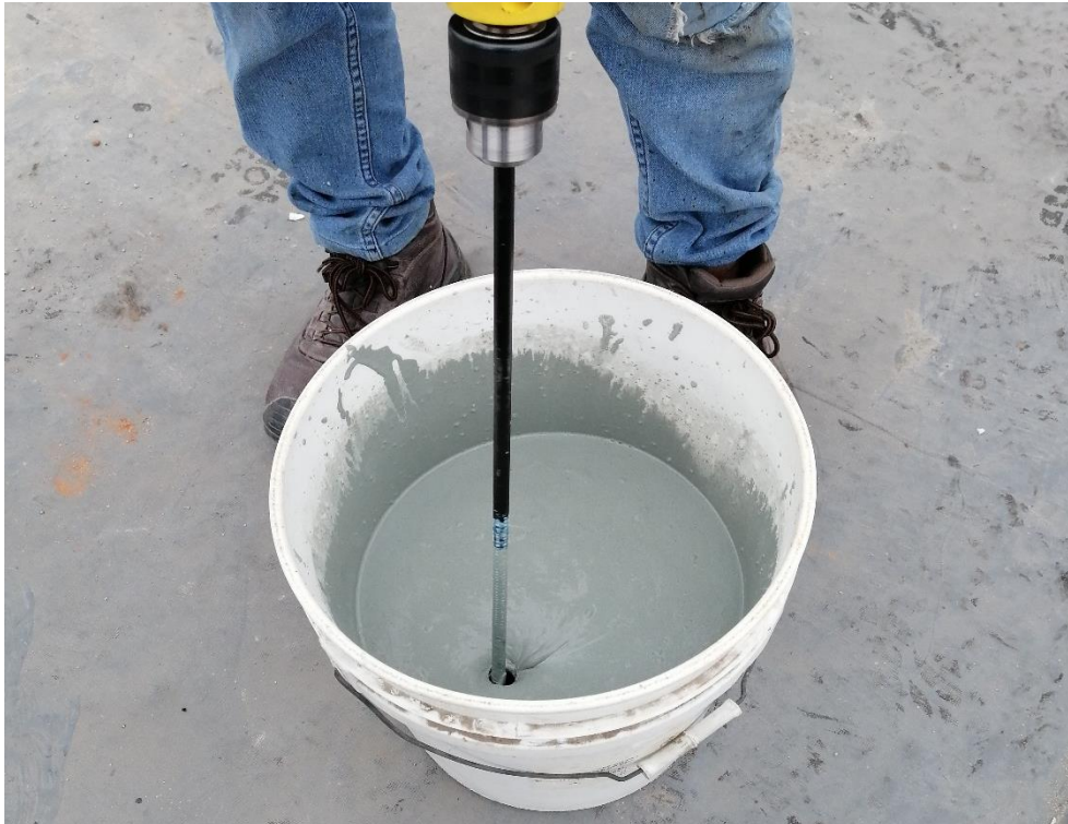
Foto N° 21: Se procedió a mezclar los componentes del mapelastic Smart Pack con un batidor para obtener una mezcla uniforme y grumos.
