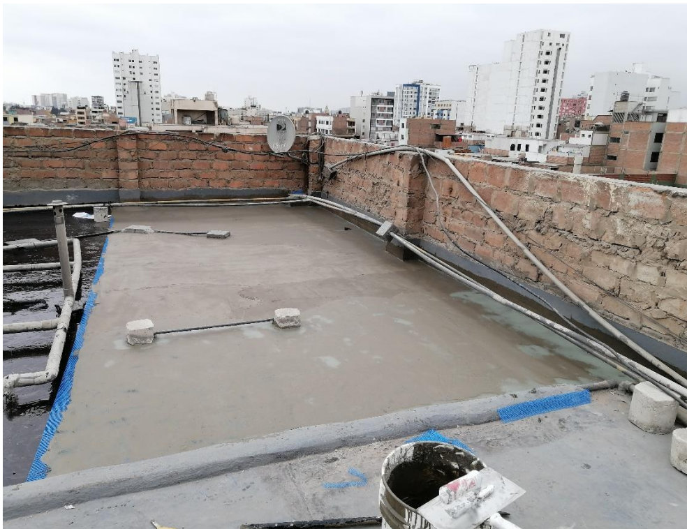
Foto N° 36: Vista general del acabado de la aplicación de la primera capa de la malla de fibra de vidrio Mapenet 150 con el mortero cementoso mapelastc Smart.
