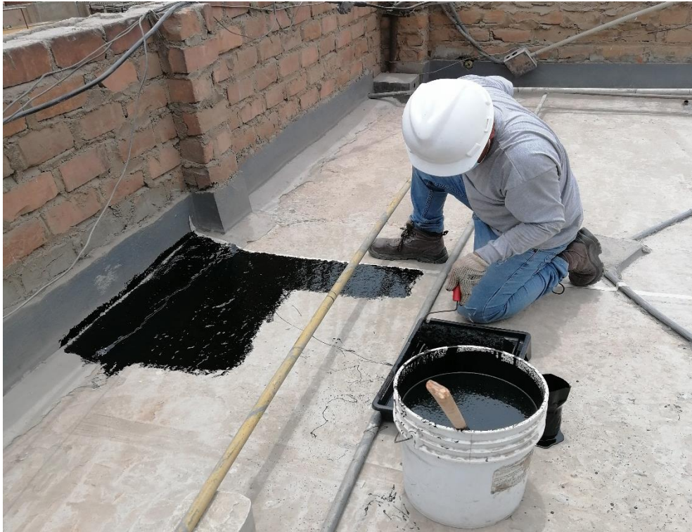
Foto N° 19: Se empezó la impermeabilización del área delimitada para la membrana líquida de poliuretano con el rodillo y ayuda de brochas para zonas poco accesibles.
