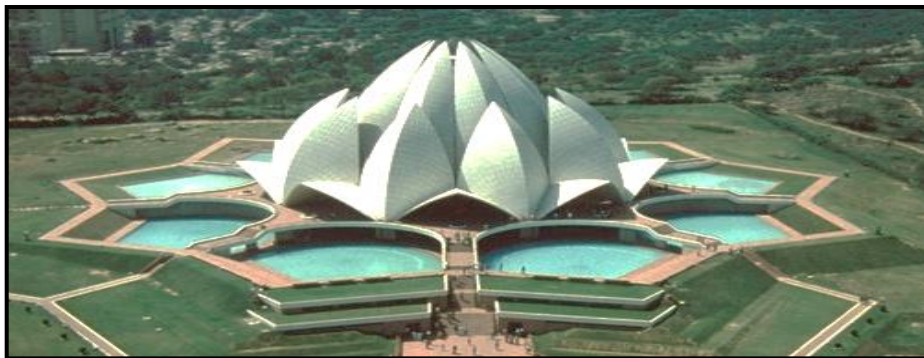
Figura 28: Templo de Loto. Armonía entre la forma y el emplazamiento. Recuperado de: http://marisamoore-imd2010.blogspot.com/2010/09/templo-de-loto.html
