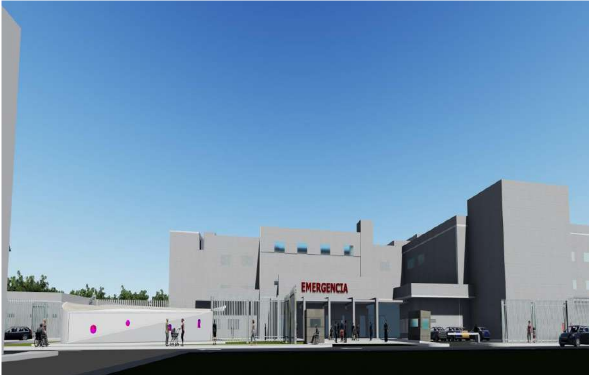
Figura 97. Vista de ingreso principal a emergencia. Elaboración propia.
