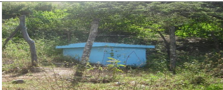
Foto N 01: cámara rompe presión en el caserío de Nitisuyo Bajo.
