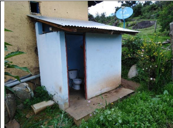
Foto N 01: Servicio higiénico con sistema biodigestor ubicado en el Centro Poblado Chalaques.
