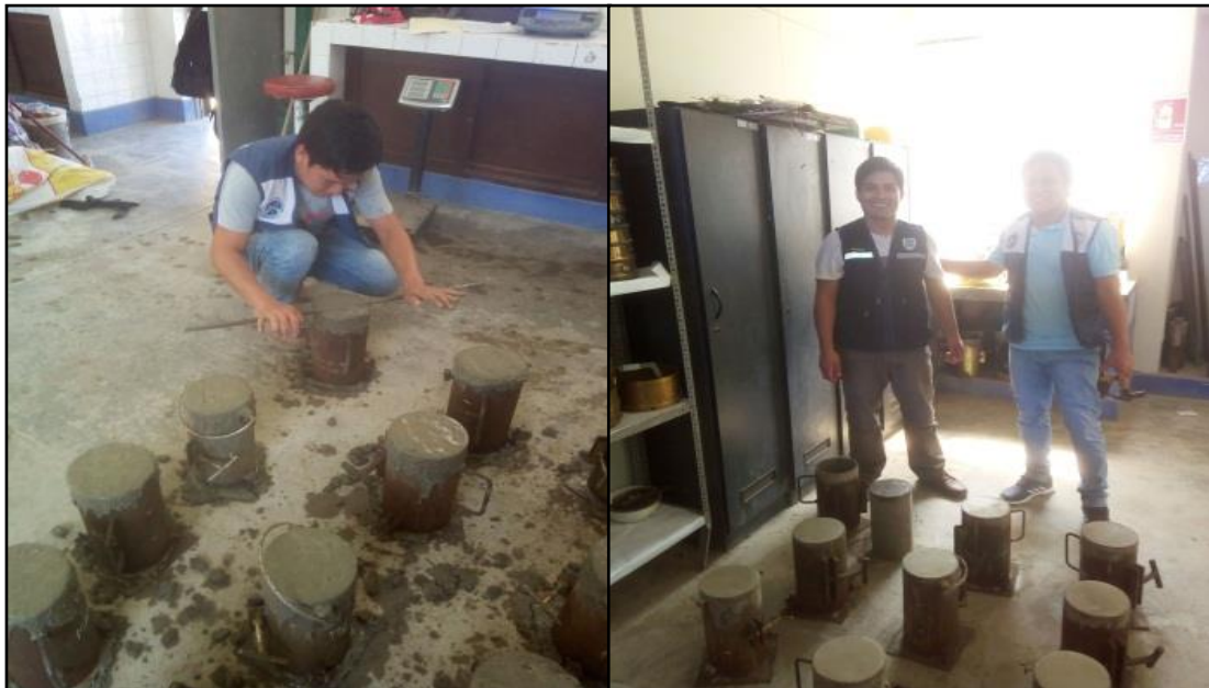
FOTO N°73, N°74: Se puede apreciar el vaciado de probetas conjuntamente con el técnico de laboratorio, así mismo el enrazado de la superficie.
