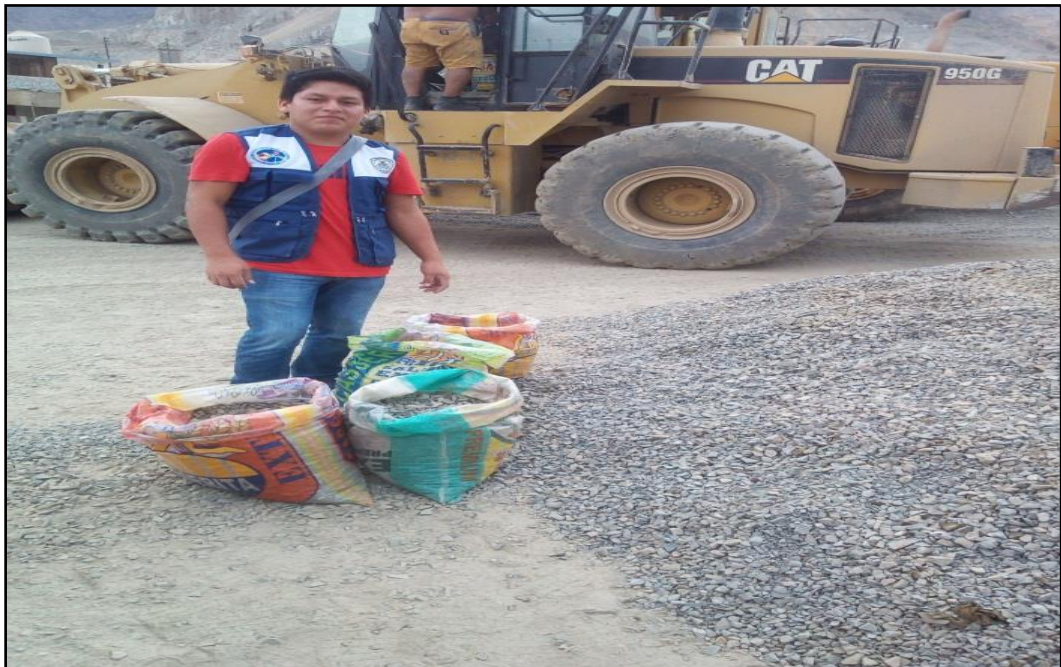
FOTO N° 01: Extracción de agregado grueso Cantera 'RUBEN'
