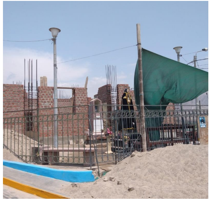
Casa de la Beatita de Humay demolida
