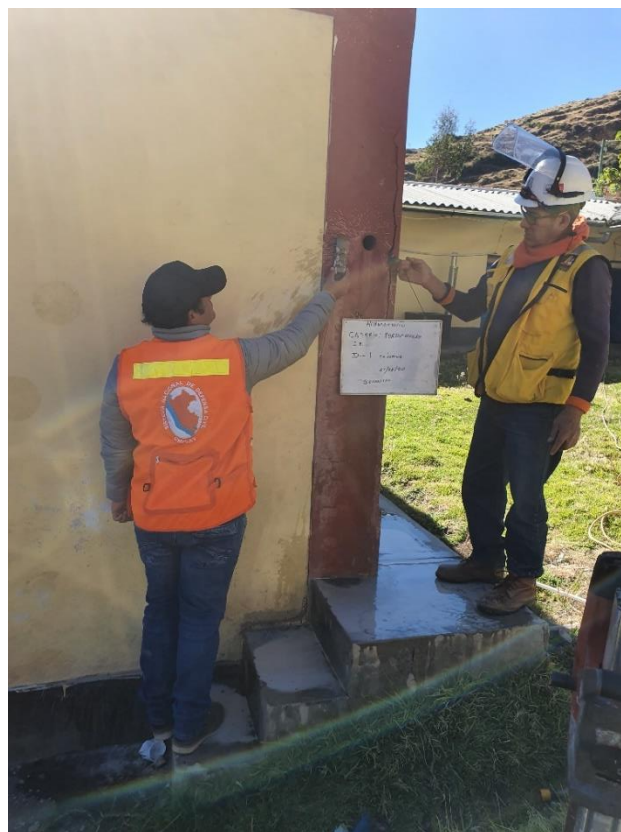
Figura 39: toma de muestra en columna esquinada D-1 para el ensayo de corazones diamantinos de las Aulas de 3° y 4° grado
