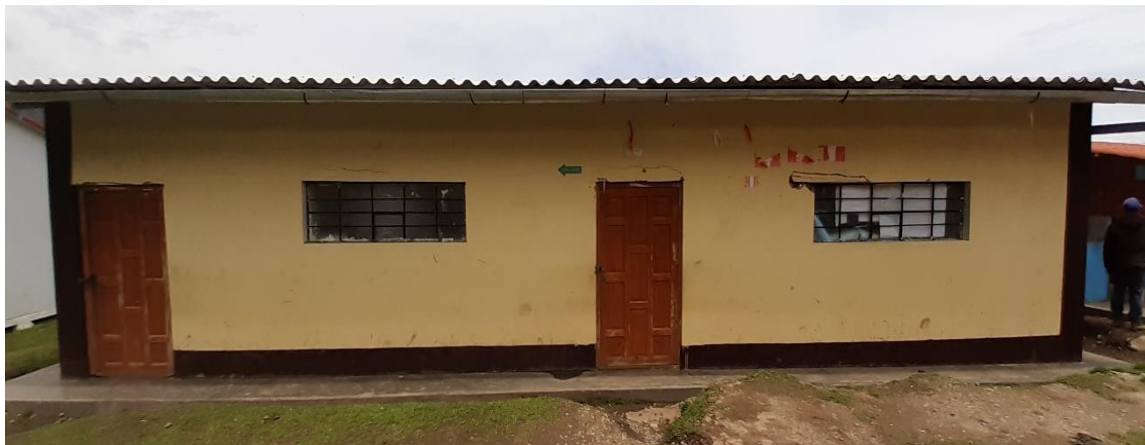
Figura 28: Aulas de la I.E. 80788 en El Caserío De Portachuelo
