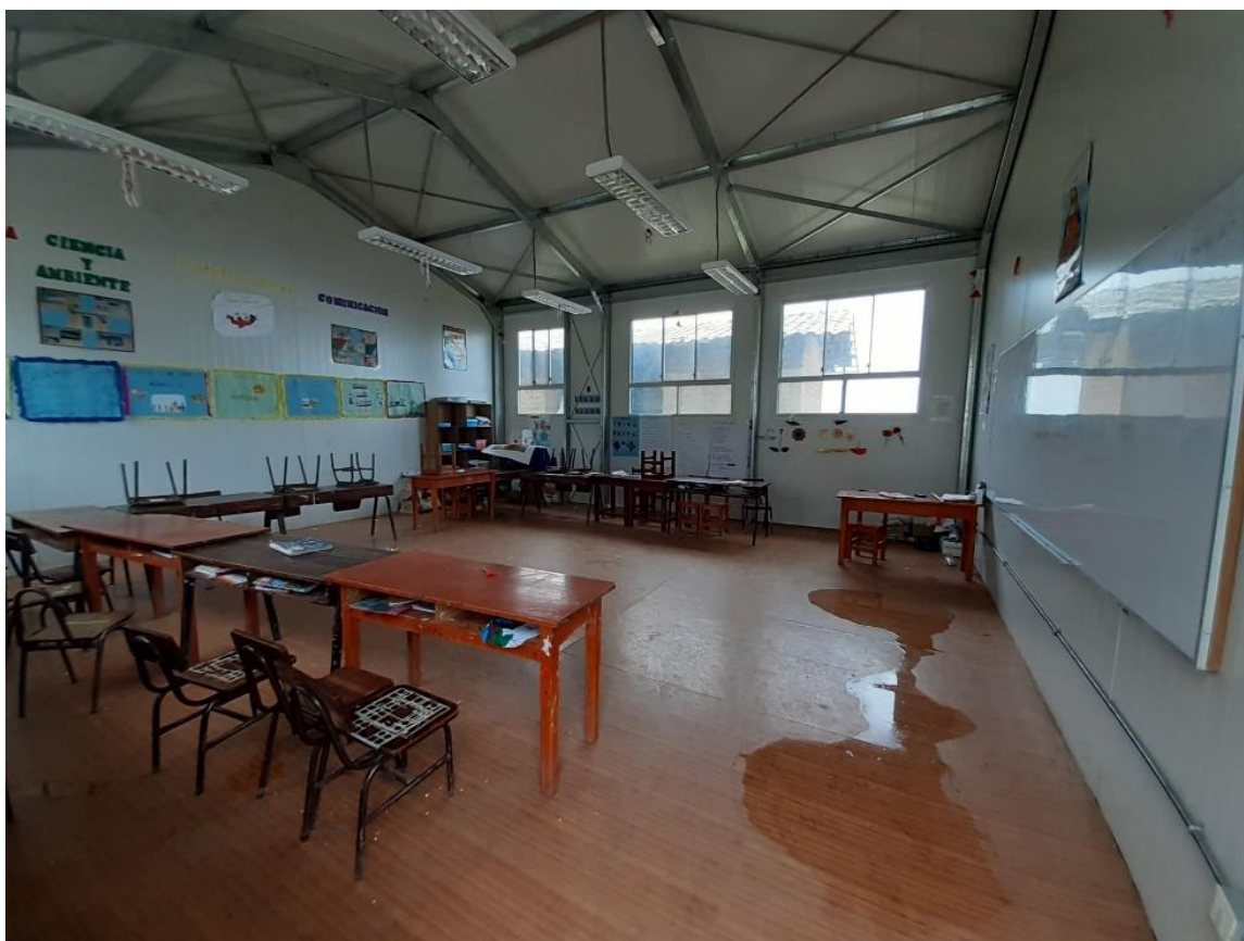
Figura 48: vista interior del Módulo pre fabricado para aula de 5 y 6 de primaria.
