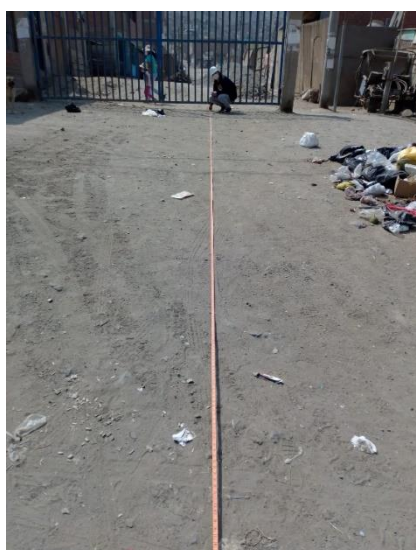
Figura 42. Distancia avenida - perímetro 27/10/2020 – 11:39
