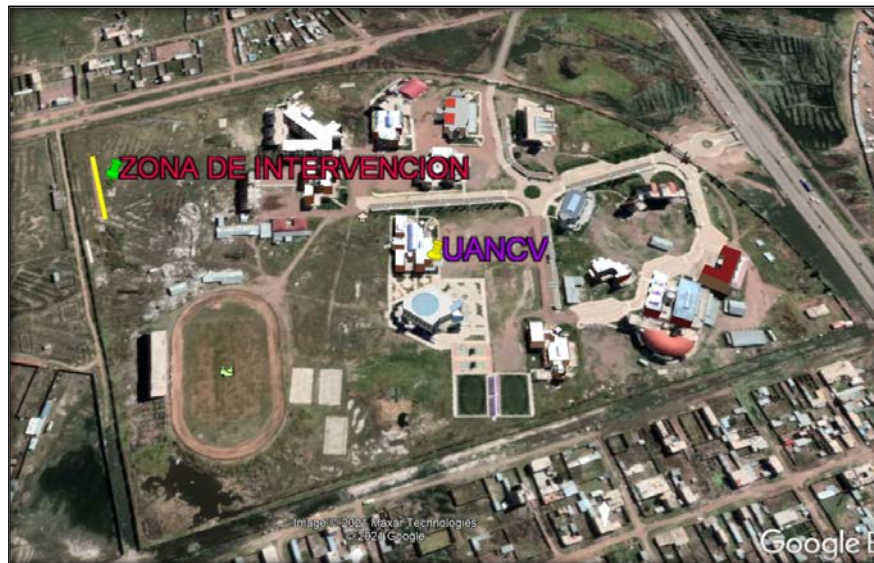
Figura 36: Ubicación de la zona de intervención.
