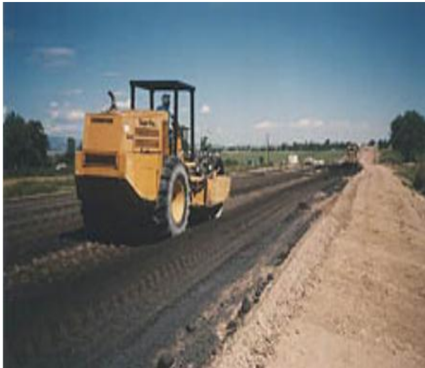
Figura 13: Mejoramiento de la subrasante.
