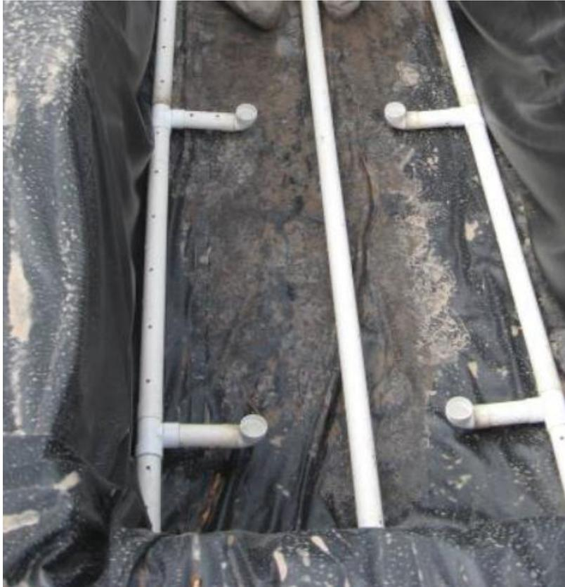
Fotografía 3. Instalación de Tuberías cribadas
