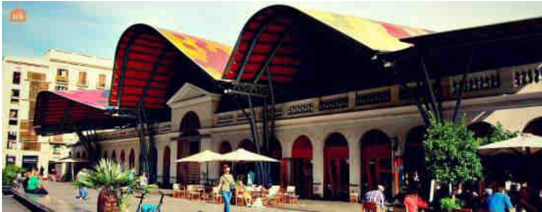
Figura 3: Finalización de la remodelación del Mercado de Santa Caterina.
