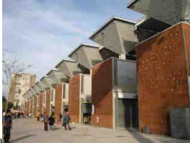
Figura 95: Vista de la fachada lateral del Mercado Tirso de
