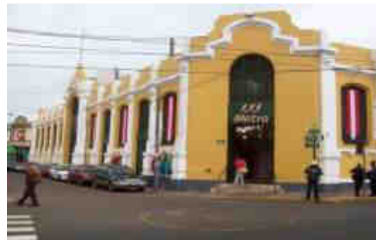
Figura 80: Fachada actual del Supermercado Metro
