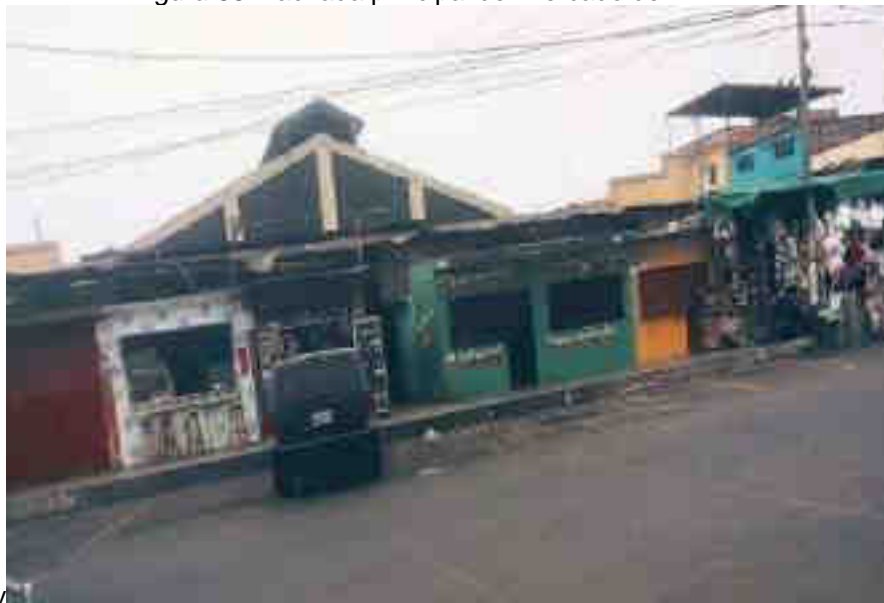
Figura 33: Fachada principal del Mercado de
