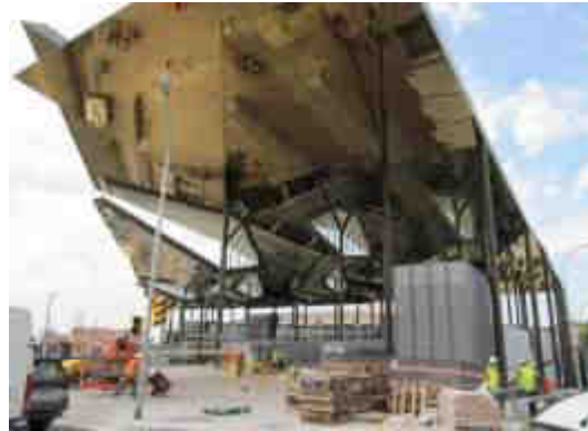
Figura 105: Obra casi finalizada
