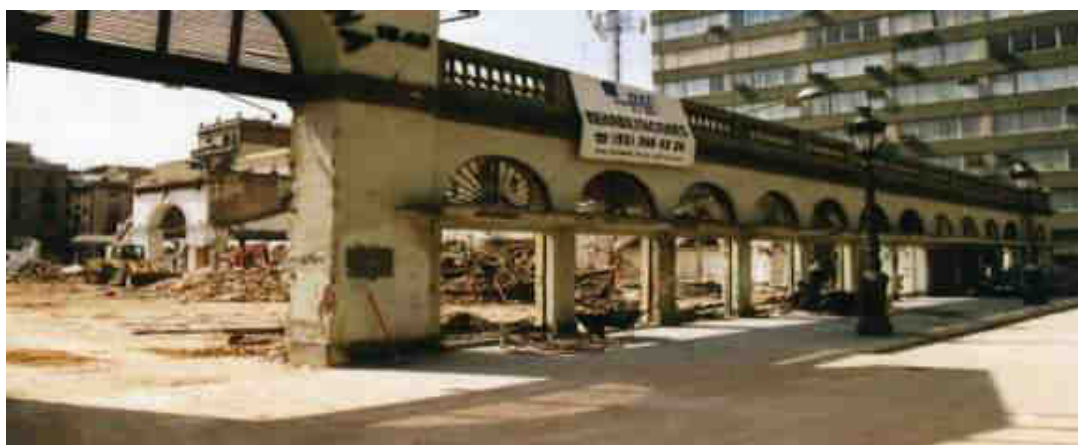
Figura 2: Remodelación del Mercado de Santa Caterina.
