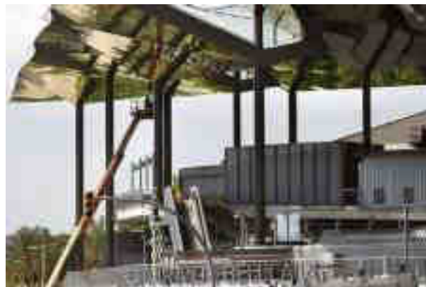
Figura 106: Colocación de las láminas en la cubierta
