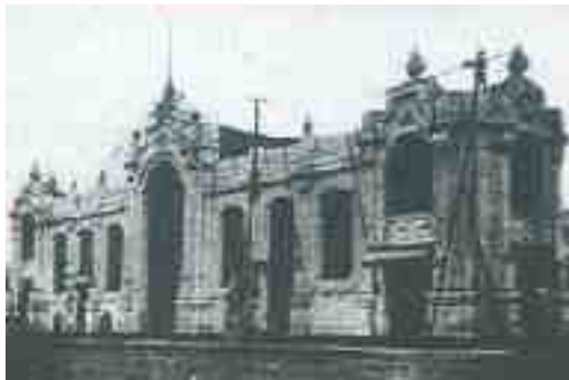
Figura 79: Fachada antigua del Mercado de Barranco.
