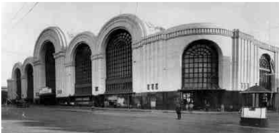
Figura 4: Fachada antigua del Mercado del Abasto.
