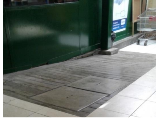
Rampa Secundaria _ Figura 09
