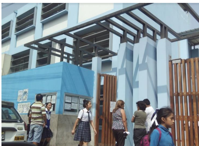
Figura 16. Ingreso principal a la I.E.E. Antenor Orrego Espinoza
