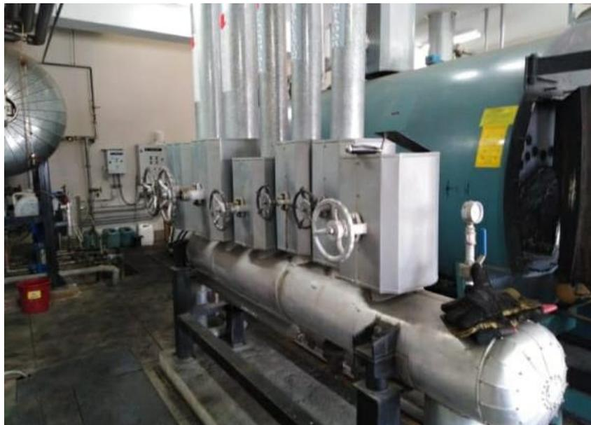
Manifold de vapor saturado
