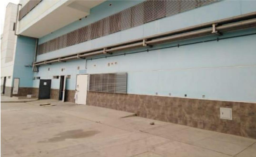
Tuberías secundarias de vapor saturado de 30 metros
