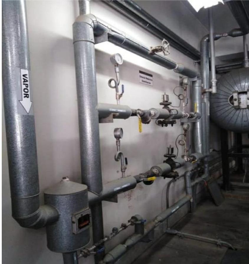
Estación Reductora de presión del área de Estilización
