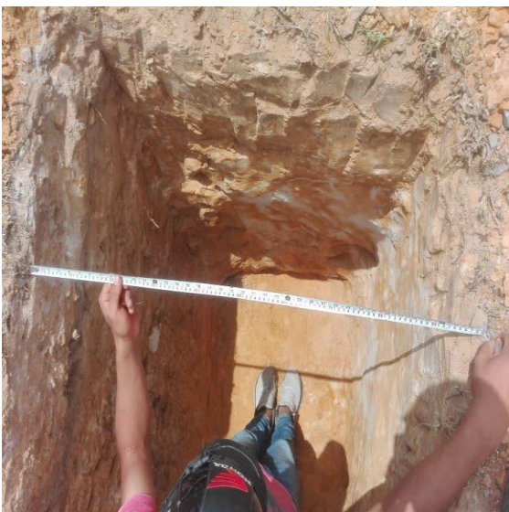
Fotografía 3 Comprobación de ancho de calicata
