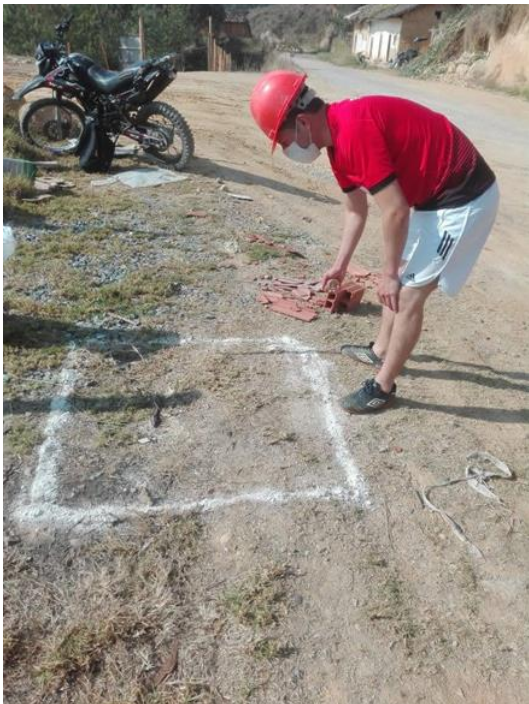
Trazo para realización de calicata
