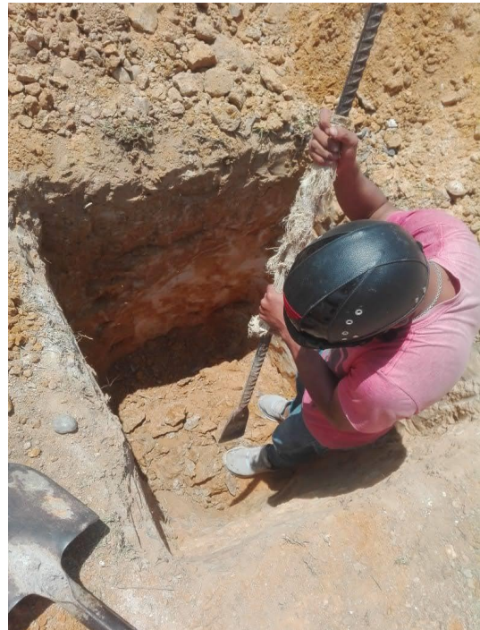
Excavación de calicata
