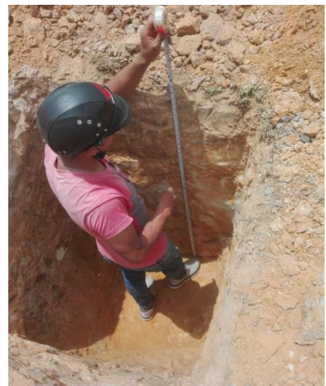
Fotografía 4 Comprobación de profundidad de calicata
