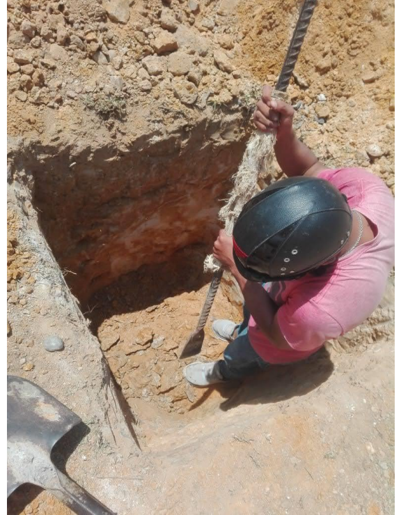
Fotografía 2 Excavación de la calicata
