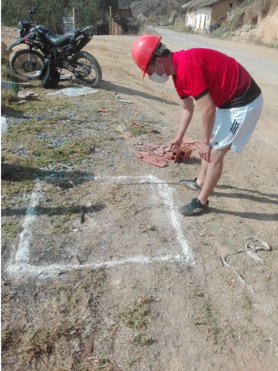
Fotografía 1 Trazo para realización de calicata
