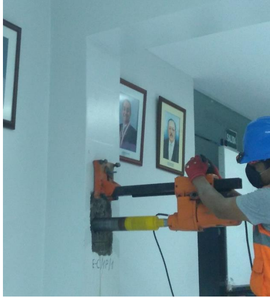
Se realizó la extracción del elemento de la columna en el punto D-C/1P-1
