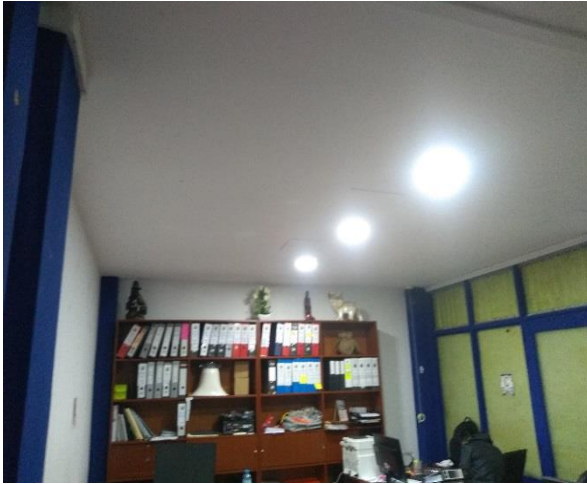
Figura 8. 3 columnas sin vigas peraltado ubicadas en el piso 2 en el área de accesoria.
