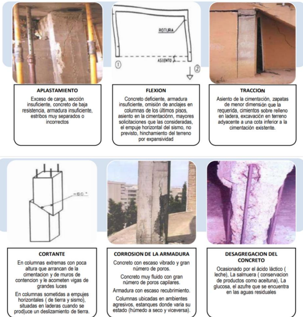
Figura 1. Fallas comunes en columnas.
