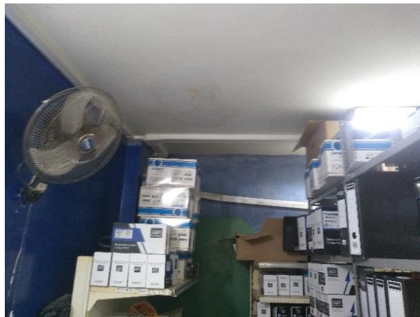
Se observa en la Área de Almacén que no observa una viga.
