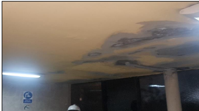
Gráfico N° 18: Reparación de techo S.S.H.H 1er nivel
