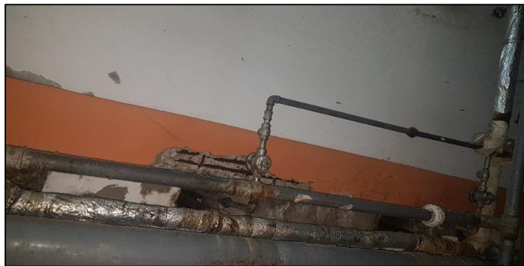
Gráfico N° 15: Estado de conservación de vigas
