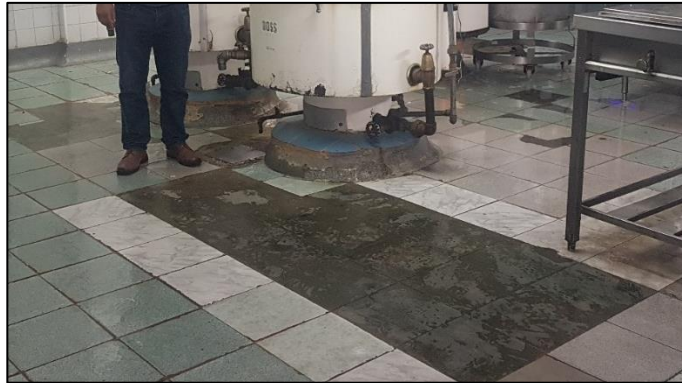
Gráfico N° 17: Reparación de la losa 2do nivel
