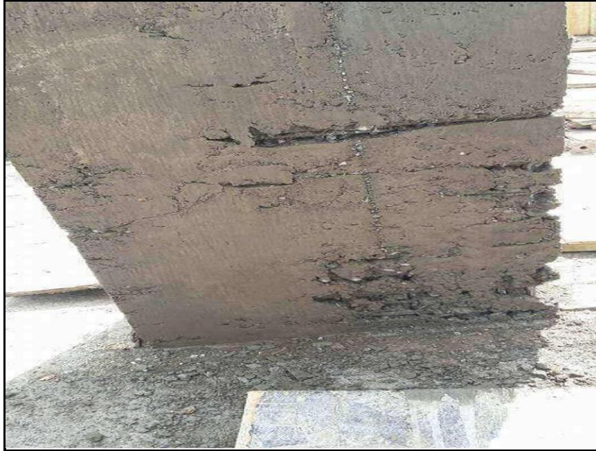
Figura 6. Segregación en el concreto.
