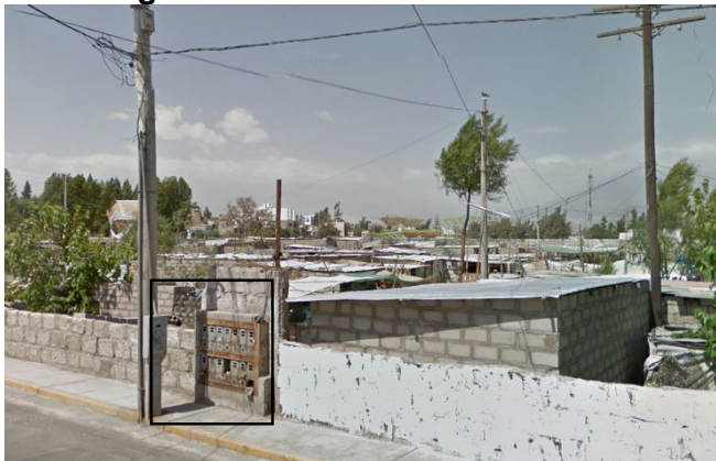
Figura 25: Medidores deteriorados
