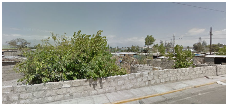
Se observa el cerco perimétrico de sillar
