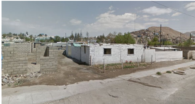
Figura 12: Vivienda de sillar
