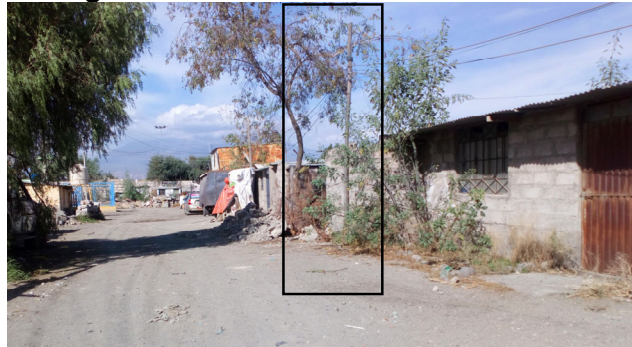
Figura 22: Poste de alumbrado eléctrico
