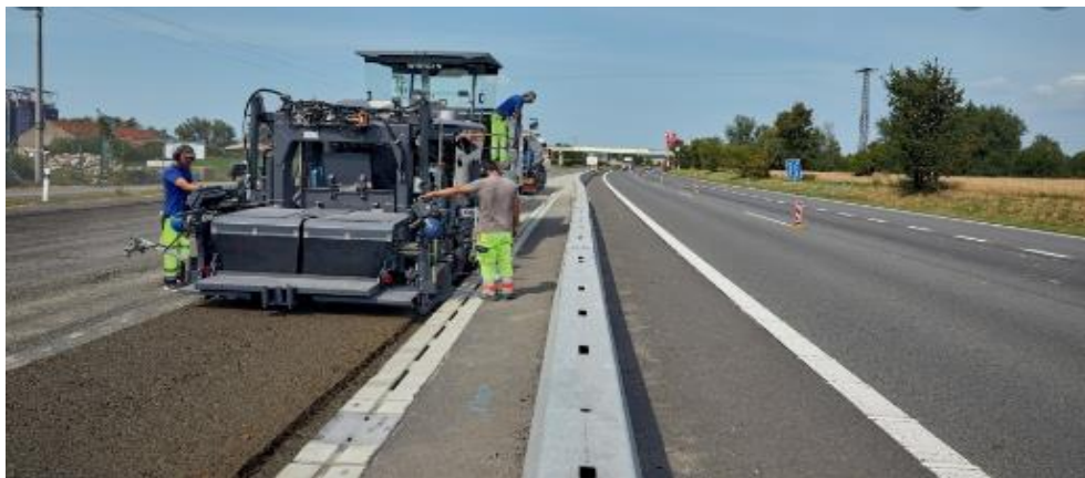
Imagen N° 03: Colocación de la capa base
