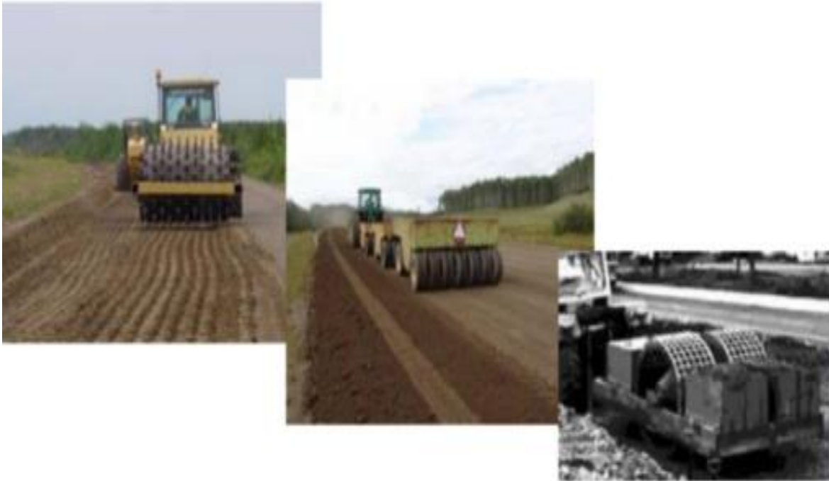
Imagen N° 01: Preparación de la subrasante
