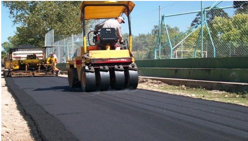
Imagen N° 04: Colocación de la superficie de rodadura
