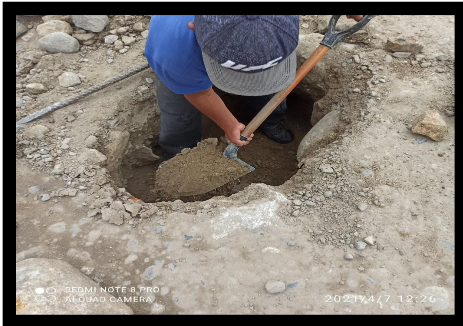
Fotografía 02: Excavación de calicata
