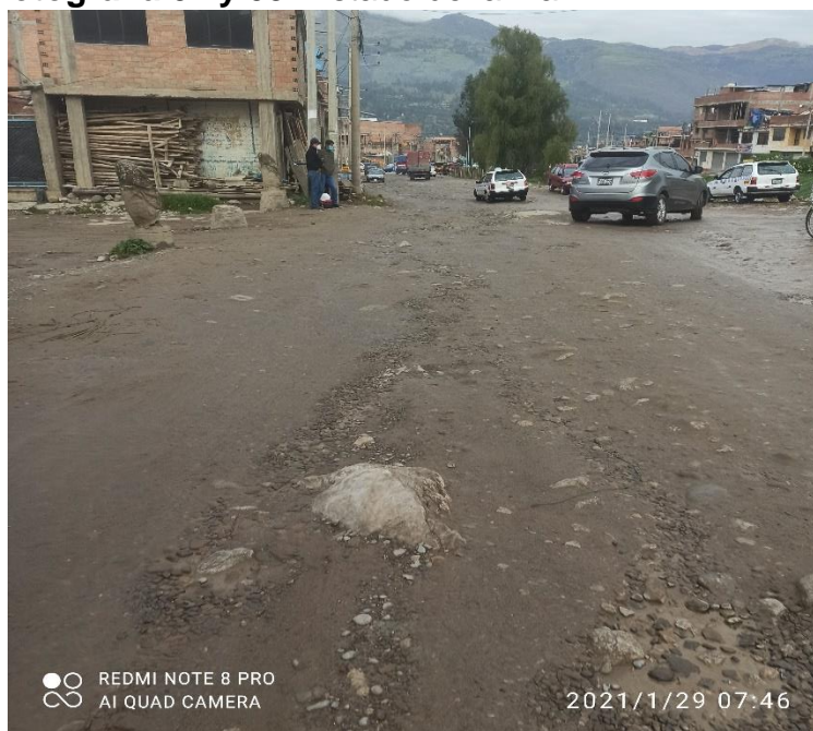
Fotografía 07 y 08: Estado de la vía
