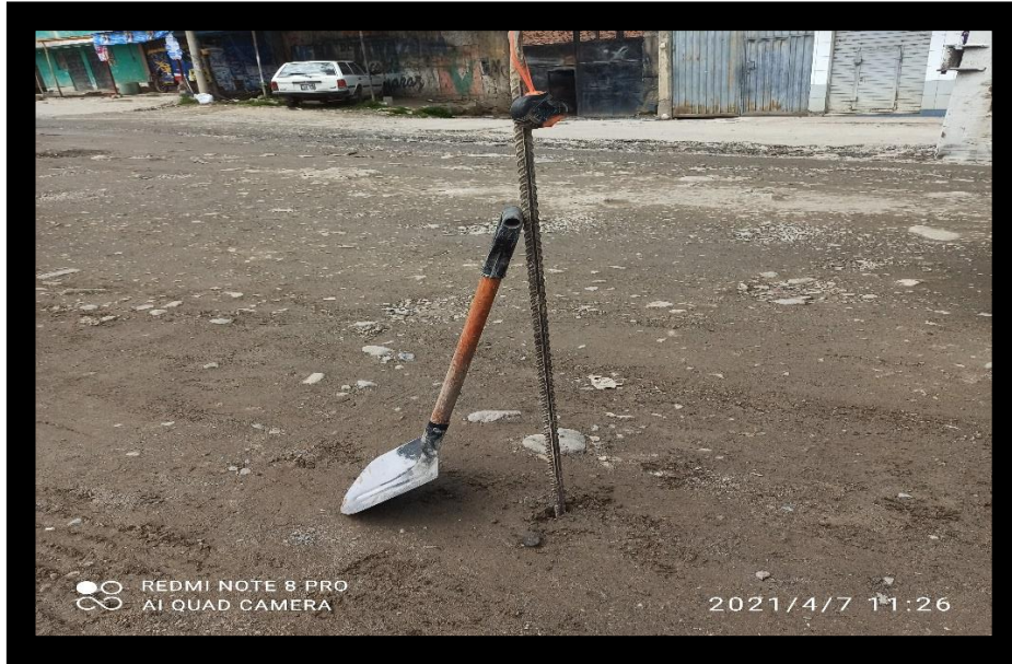
Fotografía 01: Punto seleccionado para la calicata
