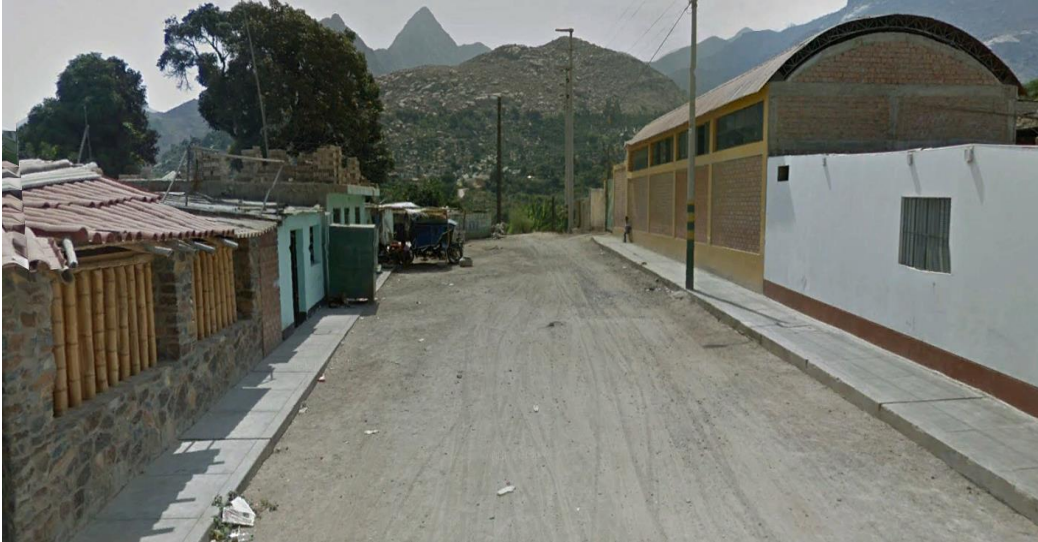
Foto 01 :vista de la calle victor maldonado vegaso sin asfaltar
