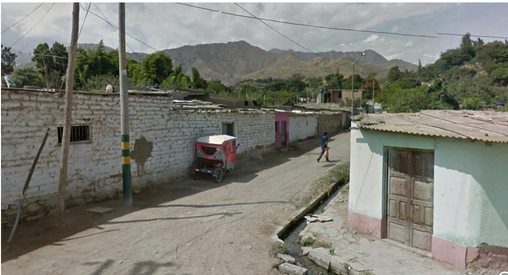
Foto 02 :vista de la calle 6 maldonado vegaso sin asfaltar
