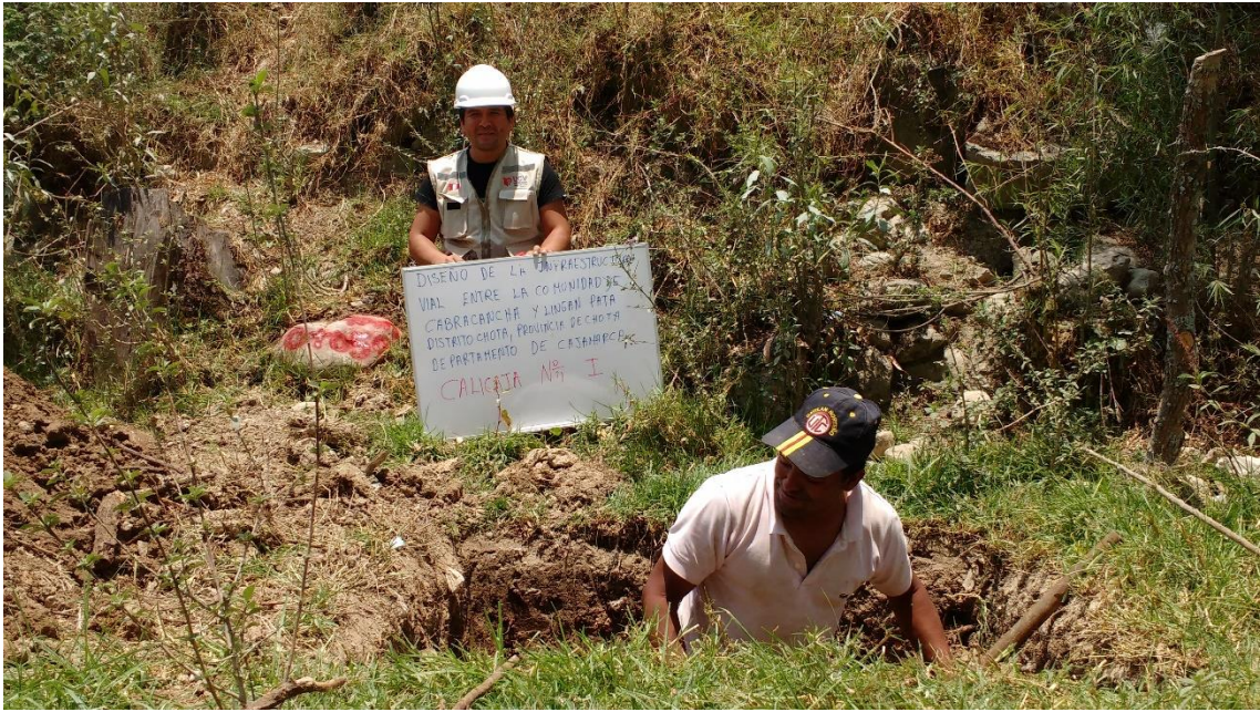
Foto N° 05: Exploración y muestreo de la calicata N°1 (C-1)
