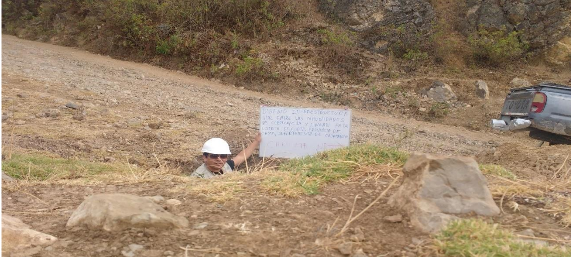
Foto N°01: Mal estado de la carretera.
