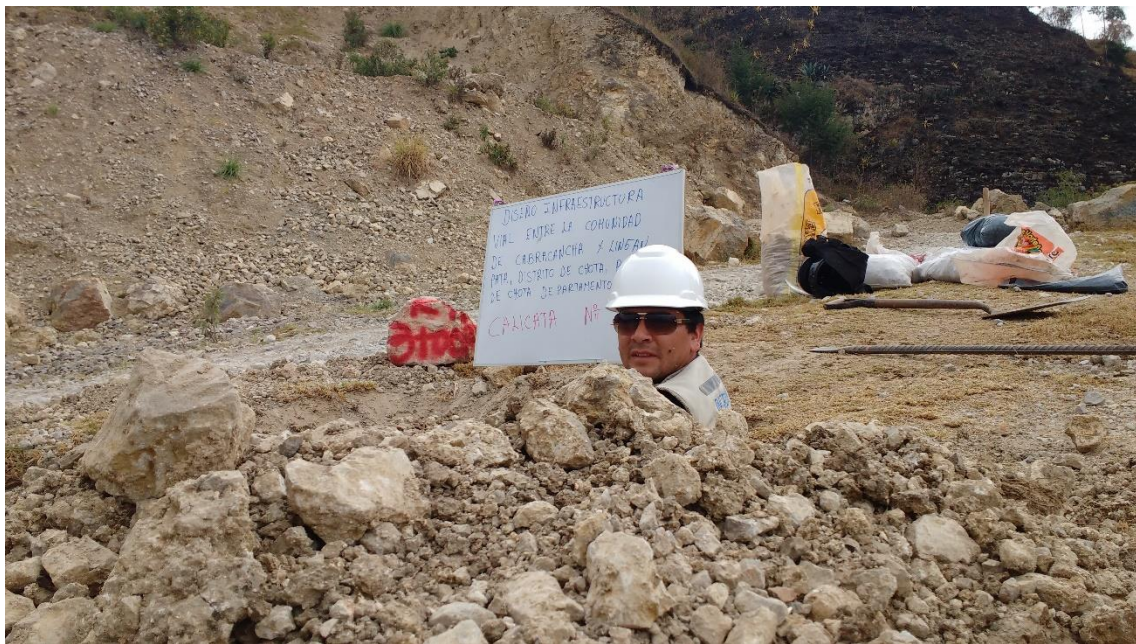
Foto N° 08: medición y muestra de la calicata C-3
