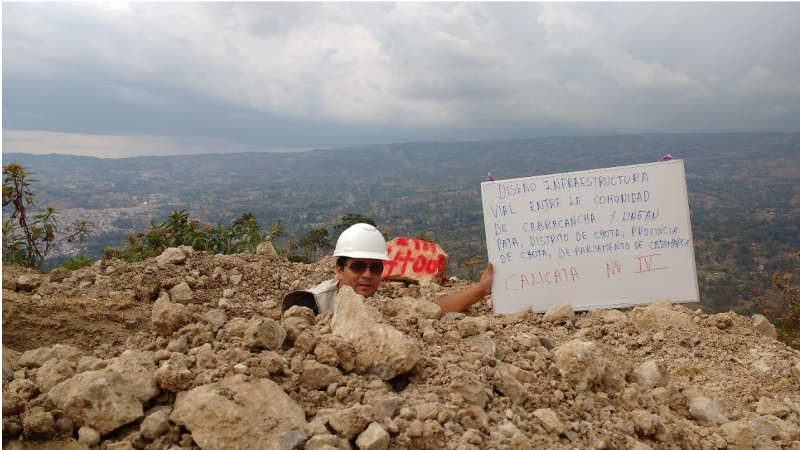
Foto N° 09: corroborando la medida de la altura escavada medición y muestra de la calicata C-4
