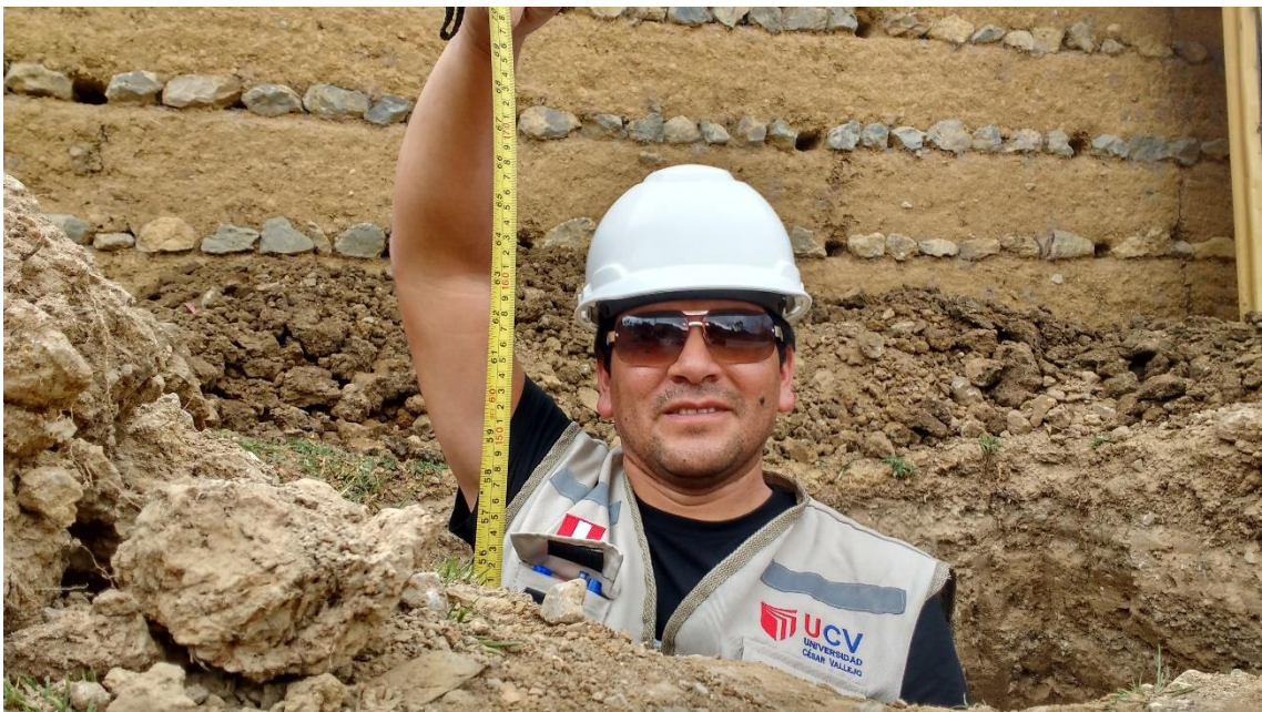
Foto N° 10: medición y muestra de la calicata C-4
