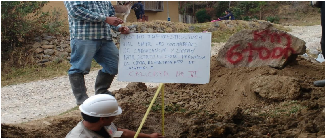
Foto N° 12: Excavación y muestra de la calicata C-6
