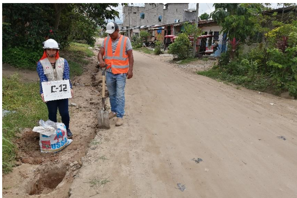
Foto N° 22: Excavación de la calicata N°12
