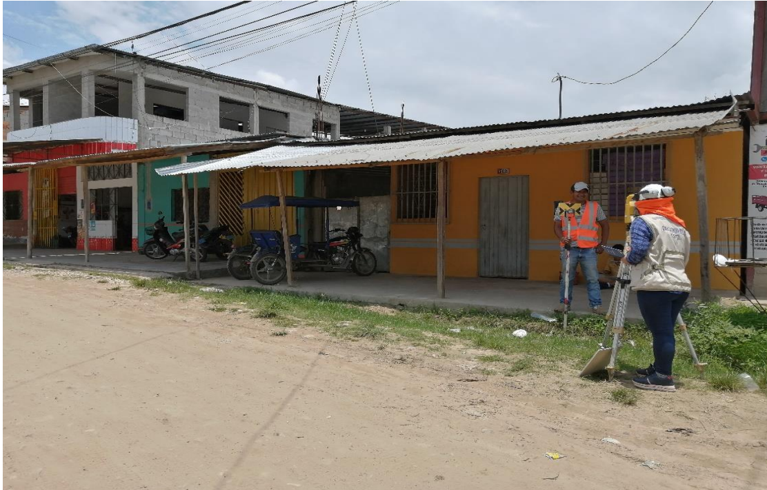
Foto N° 9: Levantamiento topográfico de elementos de una vía
