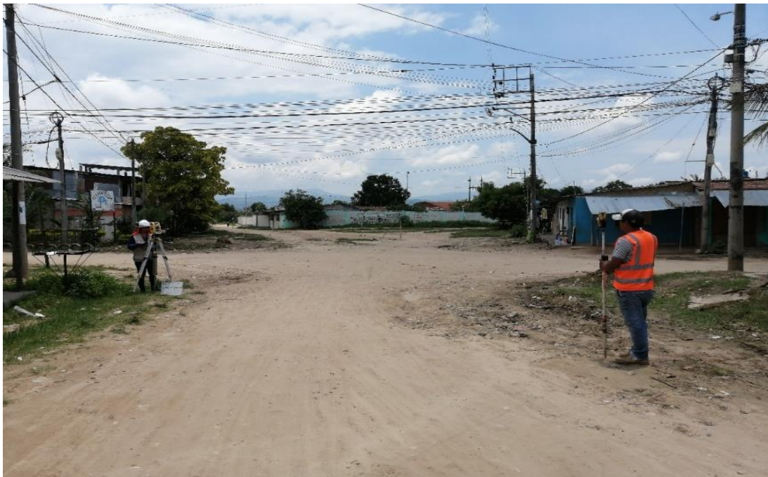
Foto N° 10: Levantamiento topográfico por poligonal cerrada
