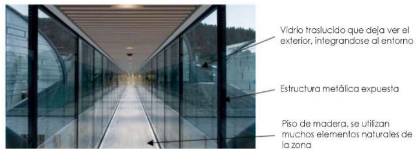
Figura 32: sistema Constructivo de TSCHUGGEN BERGOASE.
