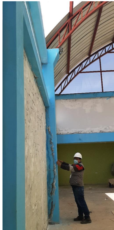
Fotografía 4. Columnas de la nave industrial
