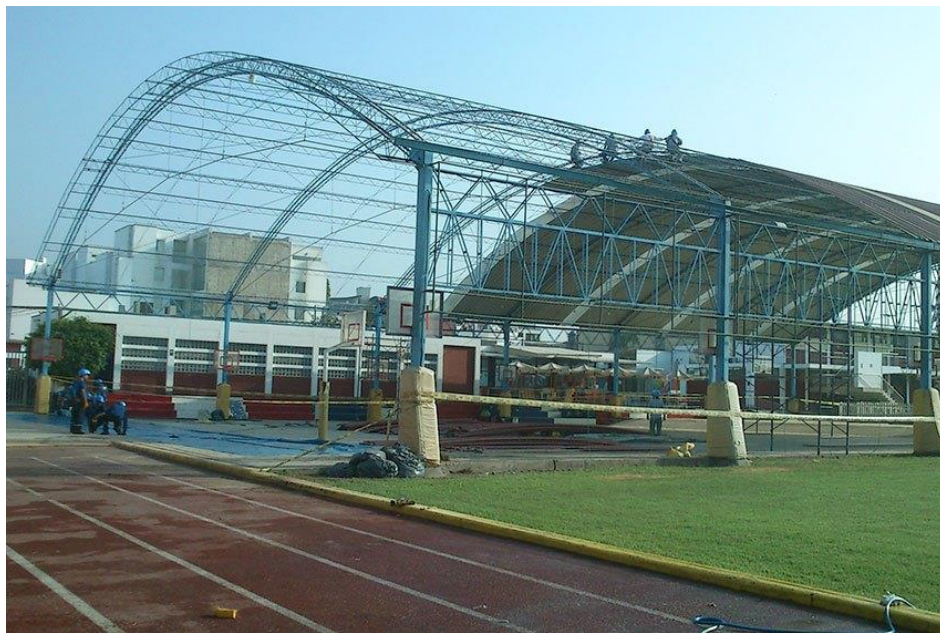
Figura 5. Techo parabólico Fuente: Acero Up
