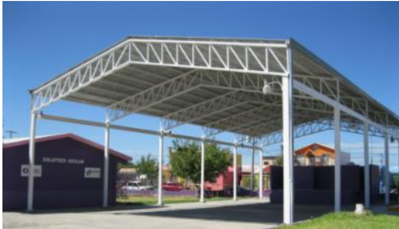
Figura 6. Techo a dos aguas
