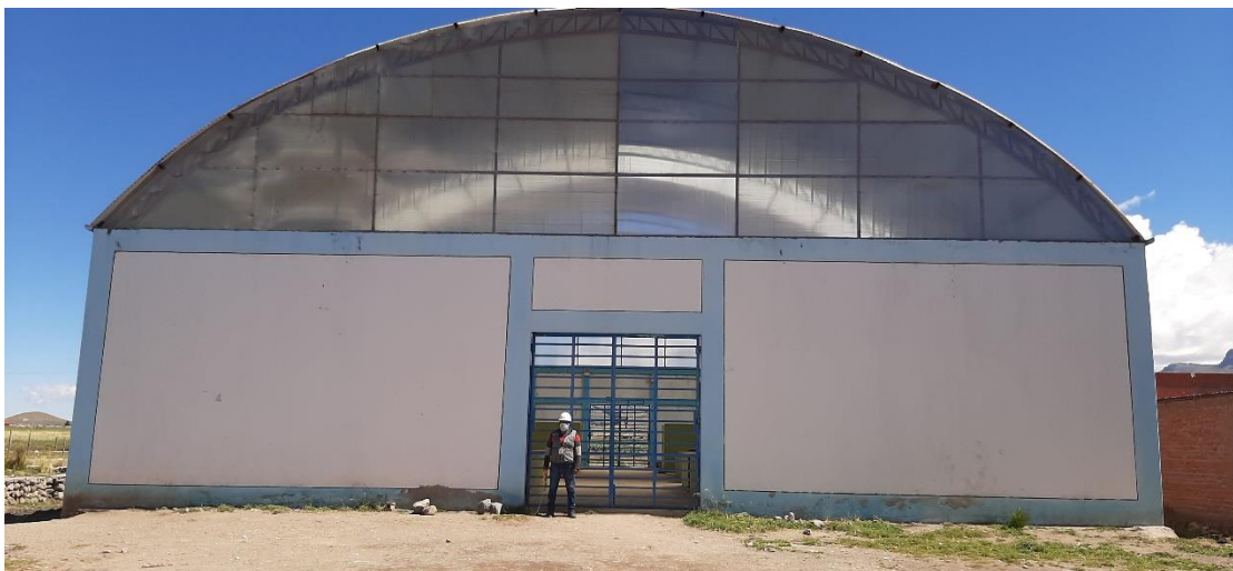
Figura 21. Vista frontal de la estructura
