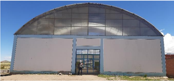
Fotografía 1. Vista frontal de nave industrial
