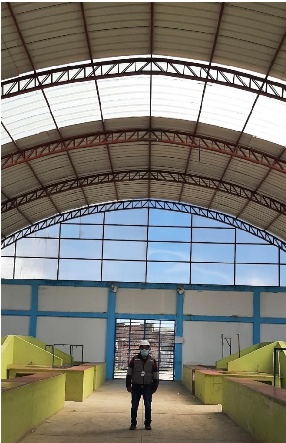
Fotografía 3. Vista interior de la nave industrial
