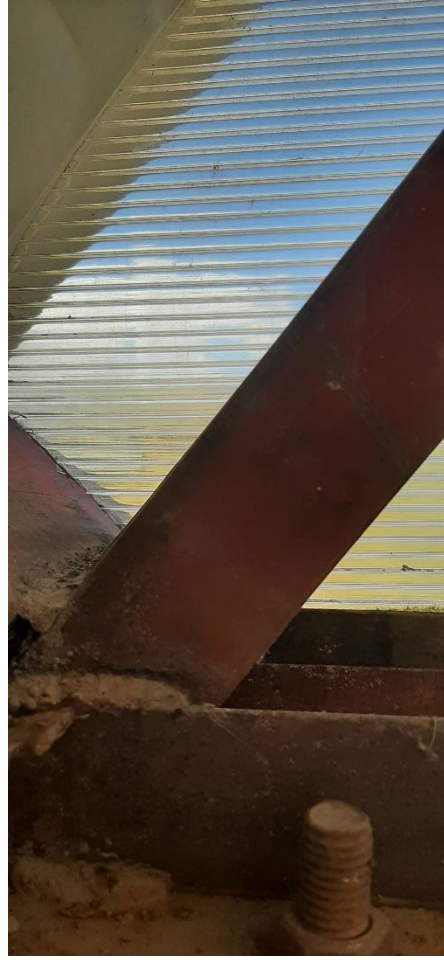
Fotografía 6. Pernos de anclaje y base metálica
