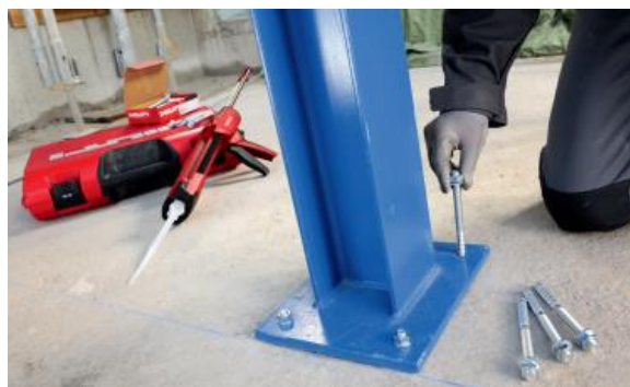
Figura 1. Estructura mixta (Concreto armado y columna de acero)
