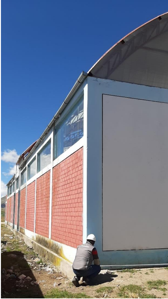
Fotografía 5. Perímetro de la nave industrial
