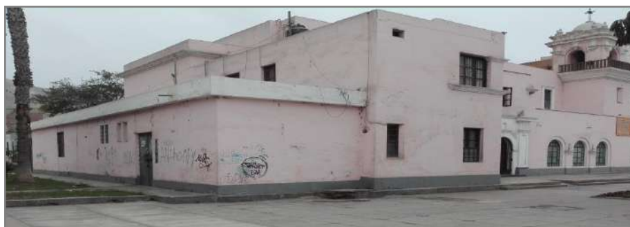
Figura N° 75 Fotografía iglesia San Pedro de Ancón Elaboración Propia
