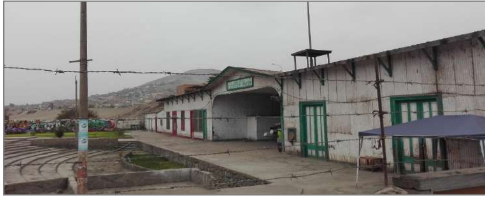
Figura N° 78 Fotografía de la antigua estación del ferrocarril junto al antiguo antifeatro Elaboración Propia
