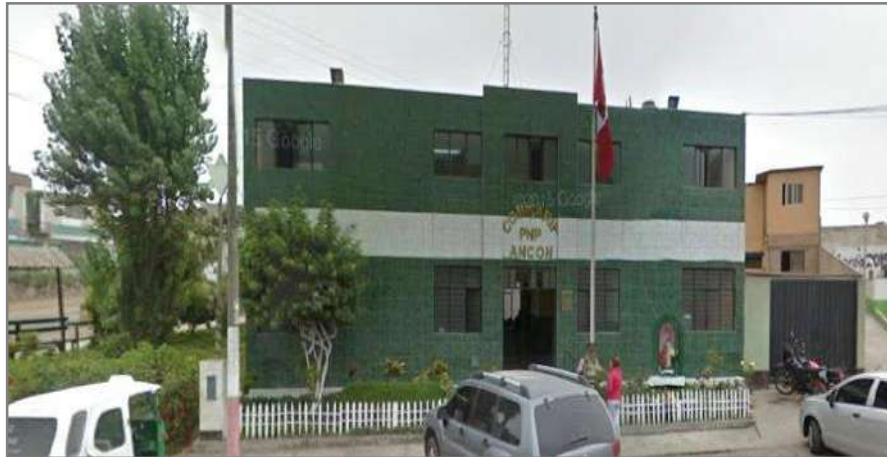
Figura N° 67 Fotografía de la Comisaria PNP Ancón Fuente: https://earth.google.com/web/
