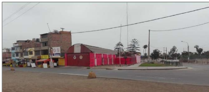
Figura N°73 Fotografía de la estación de bomberos N° 163 - Ancón Elaboración Propia
