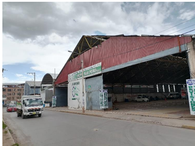
Figura 2.1 Techos de estructuras a dos aguas autoconstruida. Fuente propia.
