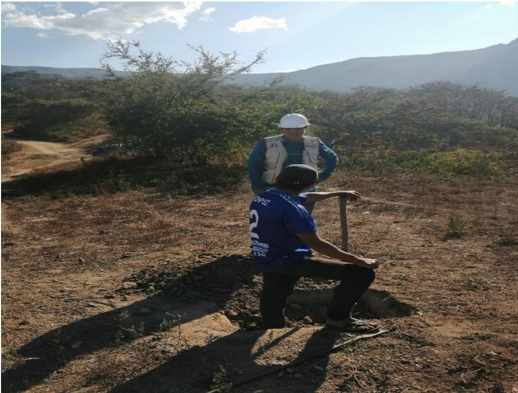
Foto N° 08. Calicata en red de distribución del caserío Cangrejera.
