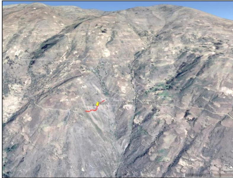
Figura 3: Vista Panorámica de la geomorfología Talud Km. 33+670 al Km. 33+880.
