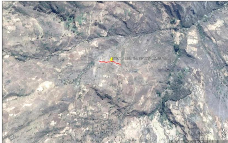
Figura 2: Vista satelital de Talud del Km. 33+670 al Km. 33+880 en la zona de estudio.
