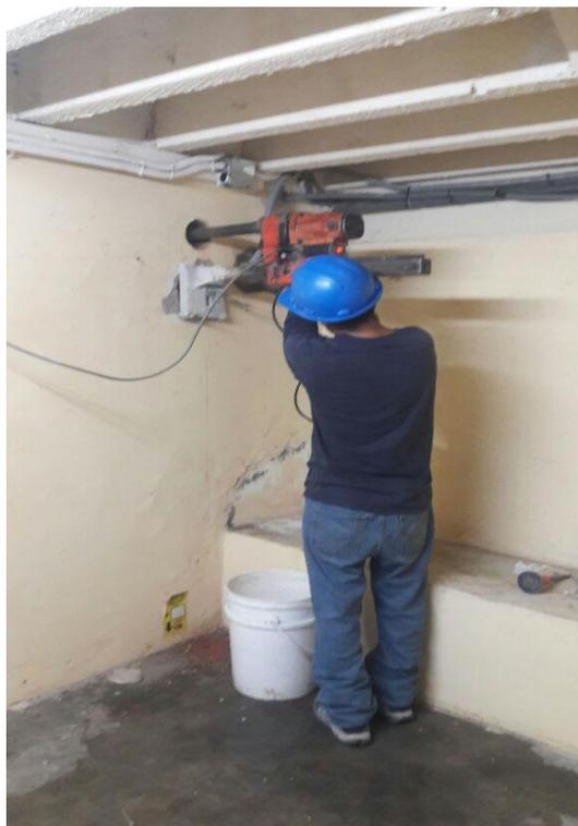
Figura 3.6. Extrayendo testigo de concreto
