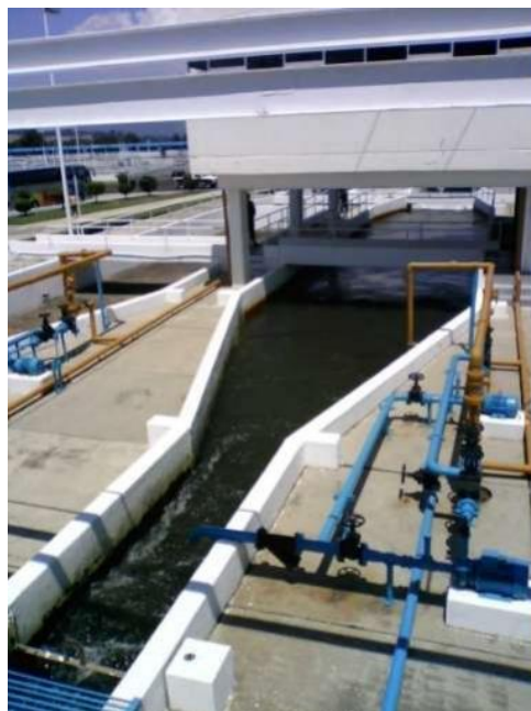
Figura 2. Canaleta Parshall.(OPS 2005)
