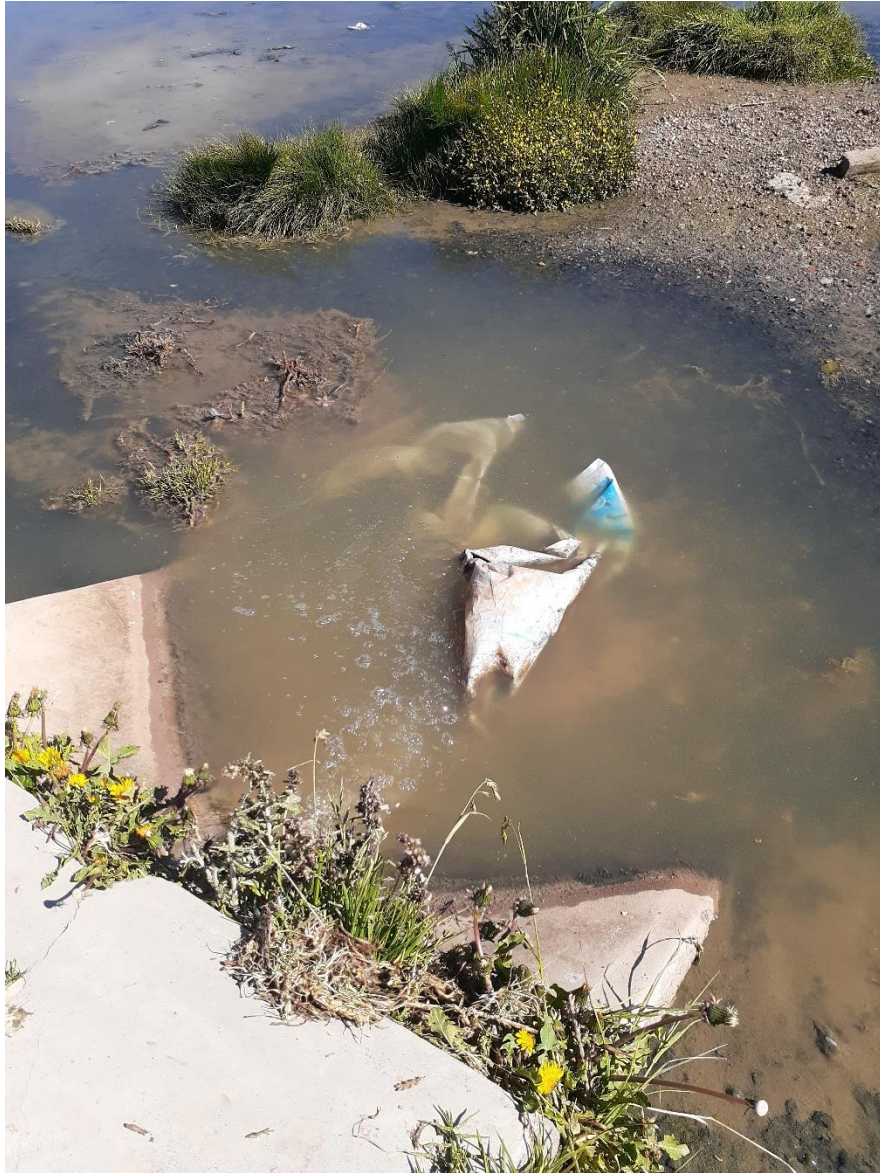
Fotografía 01. Ingreso de aguas residuales que contaminan el ambiente.
