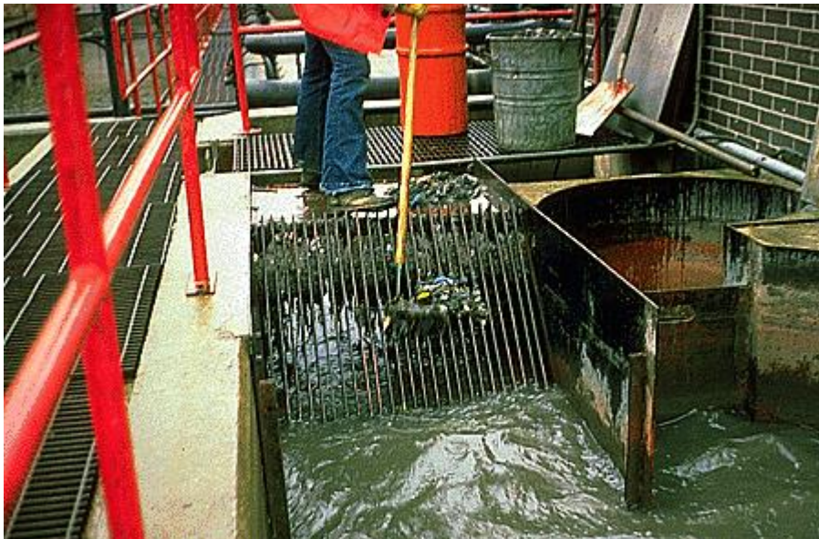
Figura 3. Desbaste de residuos en PTAR (Prieto, 2016)
