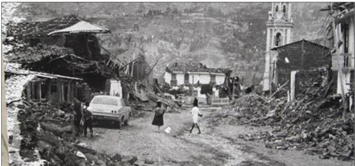
Figura 17. Estragos del terremoto ocurrido en 1970
