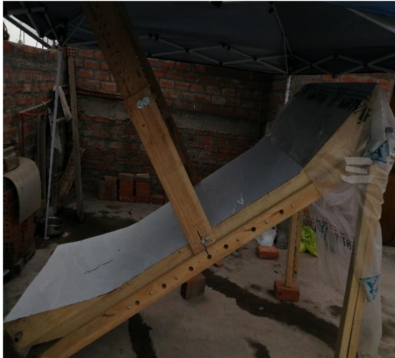
Fotografía 11. Ensamblaje del CCP
