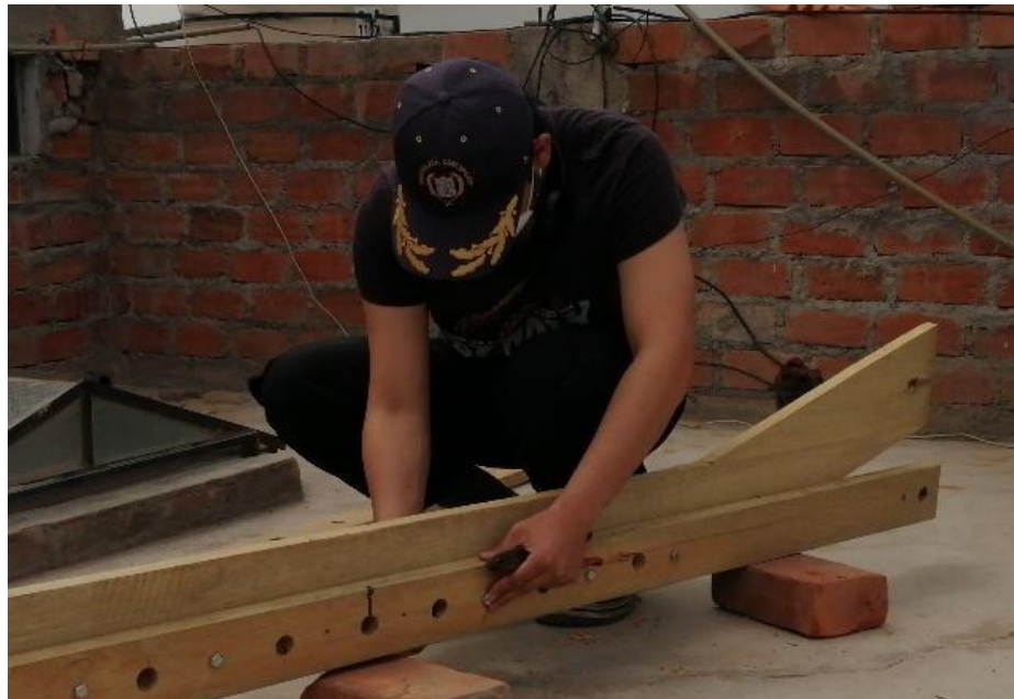
Fotografía 08. Ensamblaje del CCP
