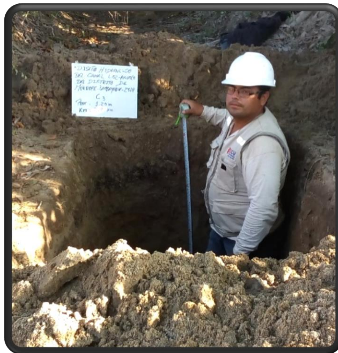
Foto N° 6. Realización de calicatas del canal Angulo con profundidad de 1. 2 m
