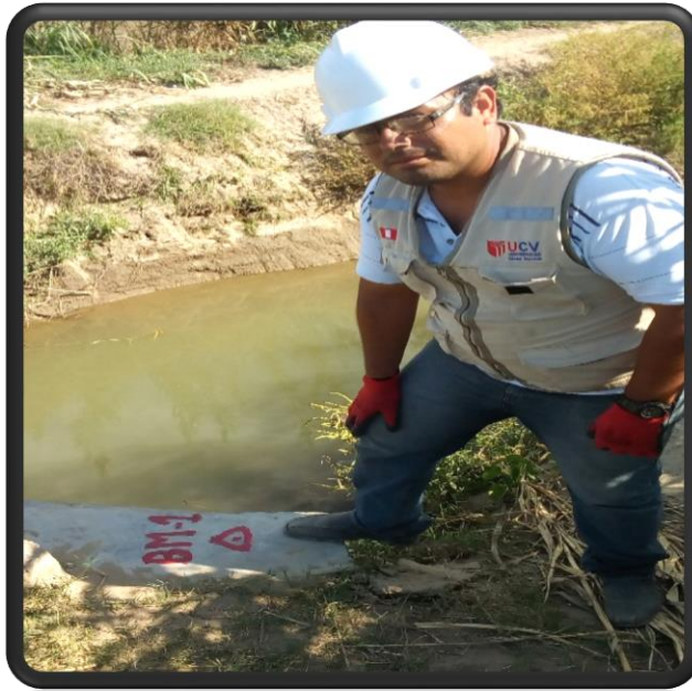
Foto N° 3. Colocación del BM -1 del canal Angolo
