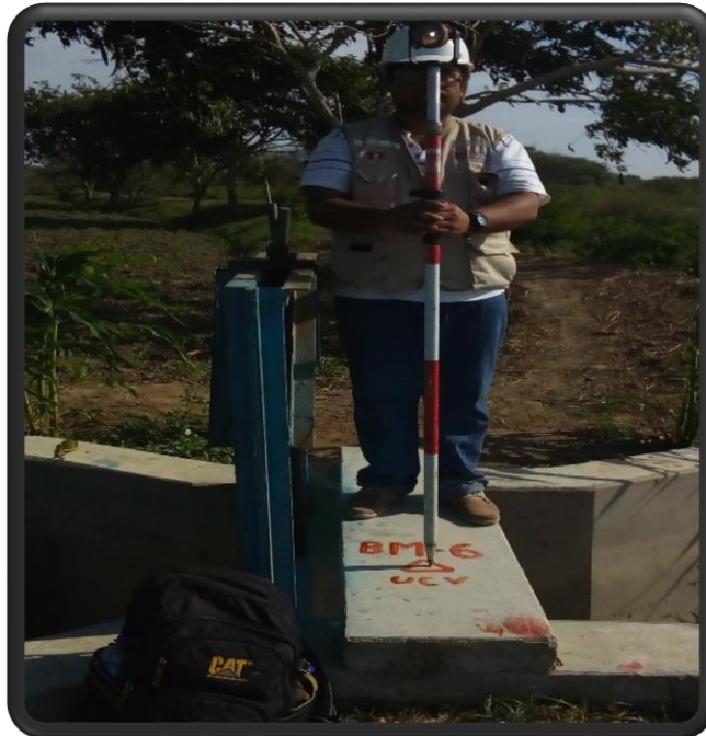
Foto N° 4. Colocación del BM -6 del canal Angolo
