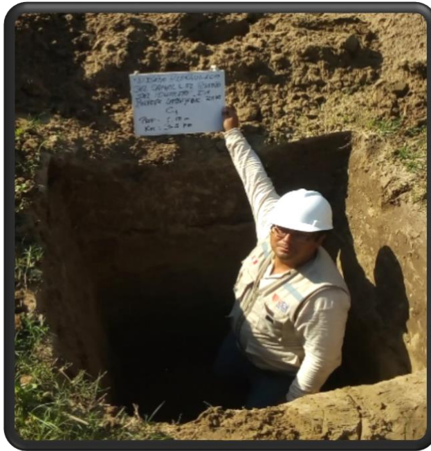
Foto N° 5. Realización de calicatas del canal Angulo con profundidad de 1. 5 m
