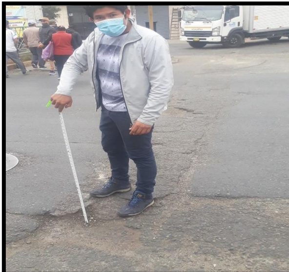
desprendimiento, baches, parcheo, ahuellamientos
