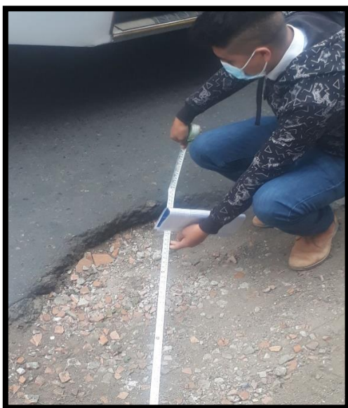
Separación de material y hueco, agrietamiento y piel de cocodrilo.
