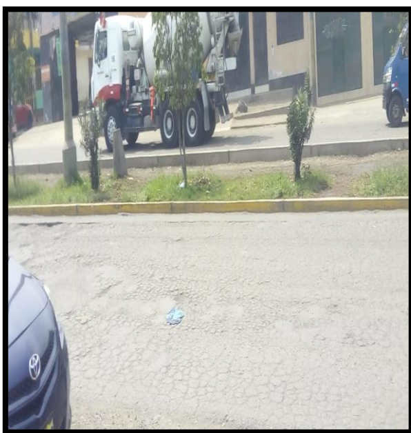
Parqueo, agrietamiento, piel de cocodrilo
