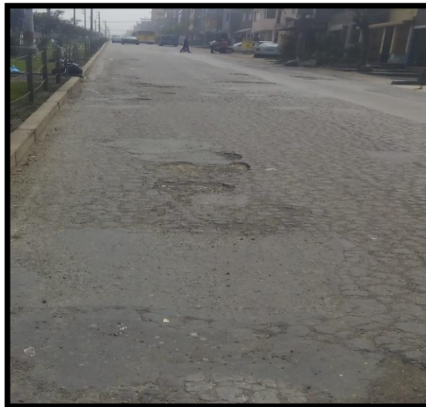
Separación de material y hueco, agrietamiento y piel de cocodrilo.
