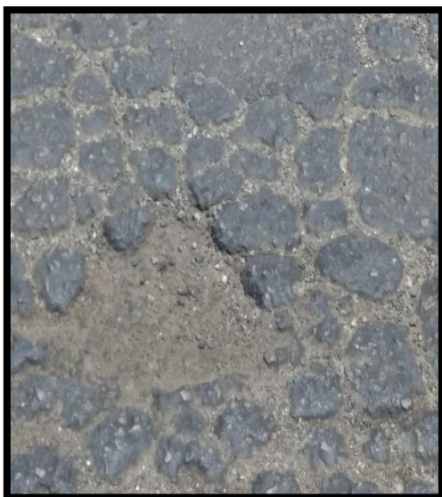
desprendimiento, baches, parcheo, ahuellamientos
