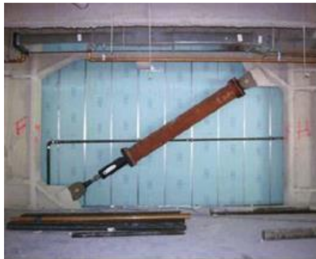
Figura 15: Fluid Viscouse Damper : (a) Características internas. (b) Incorporación a un pórtico de un edificio.
