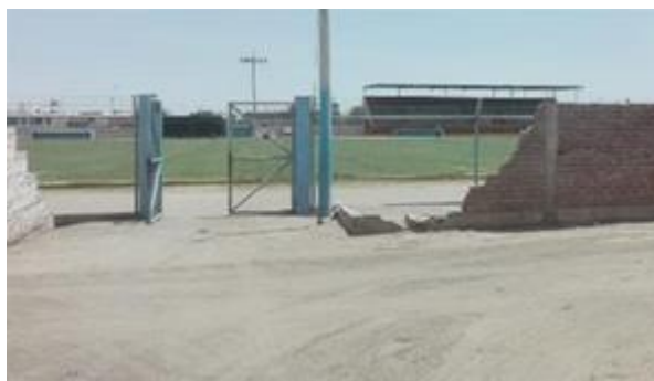
Figura 2: Estadio de Parcona. Donde se puede apreciar las malas condiciones de la estructura.
