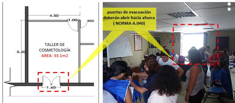
Figura 11. Puertas de evacuación.
