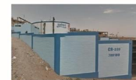
RESERVORIO DE AGUA
