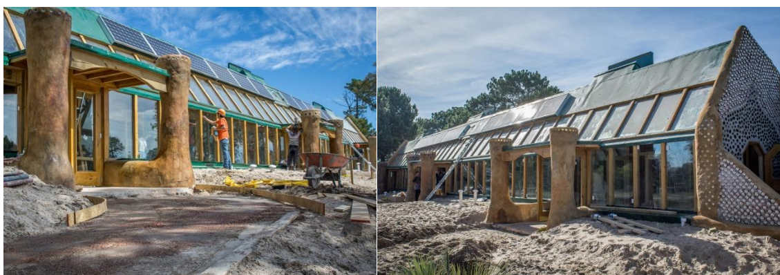
Figura N° 11: Construcción Escuela Sustentable N° 294 Jaurequiberry.
