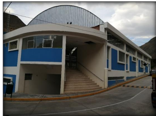
Zona de recreación sin acceso adecuado para las personas discapacitadas
