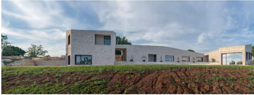
Fuente: elevación Frontal del Complejo (www.archdaily.pe)
