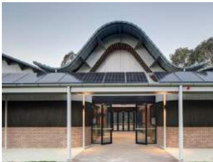
Figura 65. Fachada del Centro Comunitario Woodcroft
