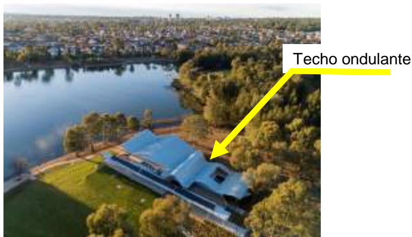
Figura 64. Entorno del centro comunitario Woodcroft Fuente: archdaily.pe
