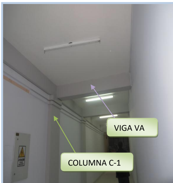
Fotos n° 2 y 3 : se verifica la presencia de vigas y columnas en ejes correspondientes al primer piso tal como lo indican los planos.
