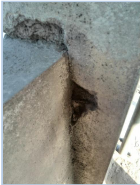
Fotos n° 6 y 7: se observa la presencia de grietas en las columnas que soportan al tanque elevado el cual en nuestro modelamiento corresponde a las columnas del quinto piso
