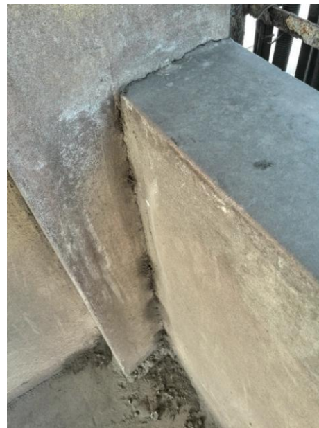
Fotos n° 6 y 7: se observa la presencia de grietas en las columnas que soportan al tanque elevado el cual en nuestro modelamiento corresponde a las columnas del quinto piso
