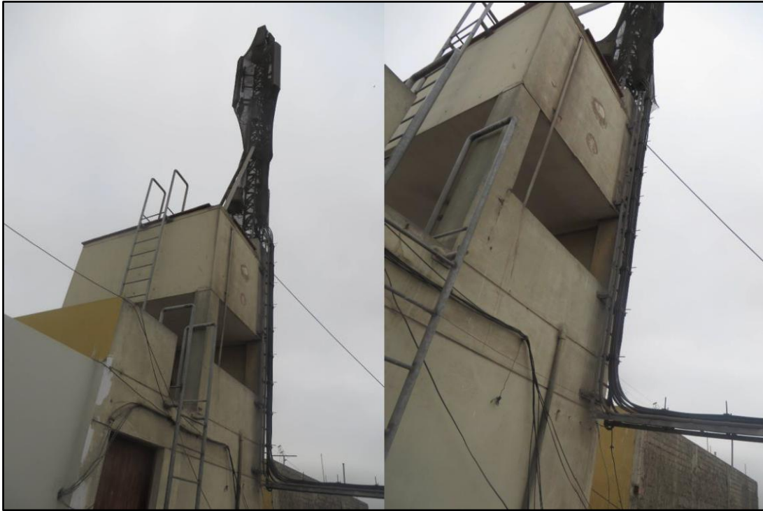
Fotos n° 4 y 5: vista frontal del tanque elevado el cual se encuentra en la azotea en la misma dirección que la escalera principal.
