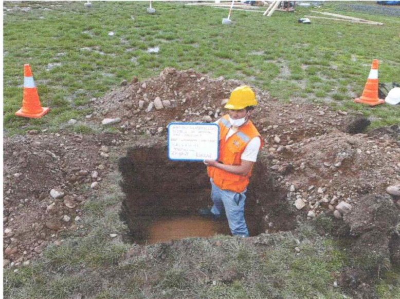
FOTO N°1: VISTA PANORAMICA DE LA EXCAVACIÓN DE LA CALICATA 01
