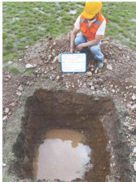
FOTO N°2: DETALLE DE ESTRATOS Y NAPA FREÁTICA PRESENTE EN CALICATA 01
