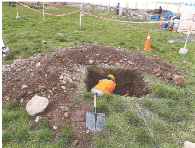
FOTO N°6: PROCESO DE EXCAVACIÓN DE LA CALICATA 03
