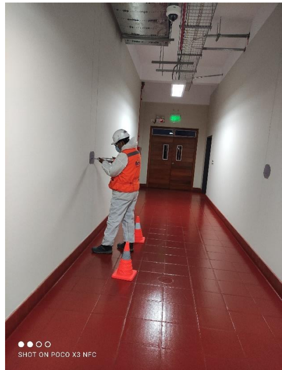
Fotografía 04. Inicio de recopilación de datos en columnas y muros de corte dentro del hospital.
