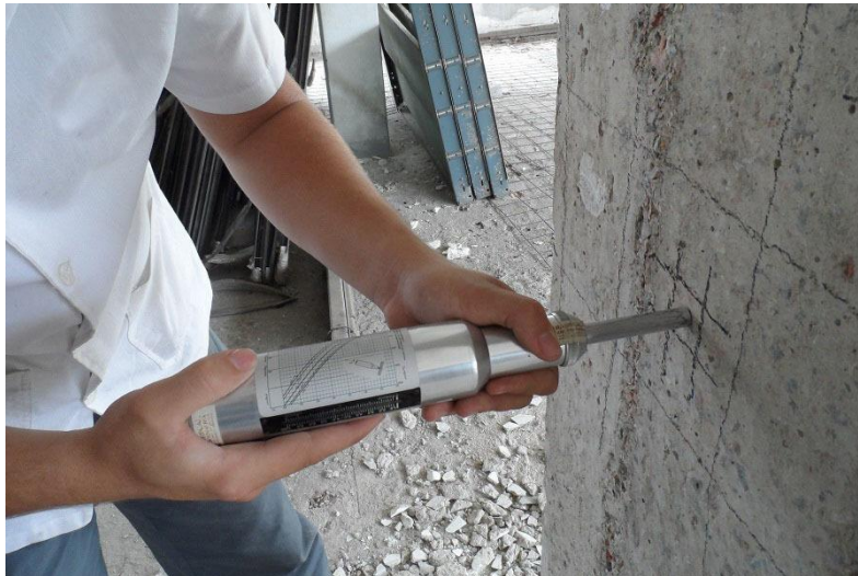
Figura 5. Aplicación del Esclerómetro
