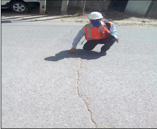
Figura 2. Grietas transversales
