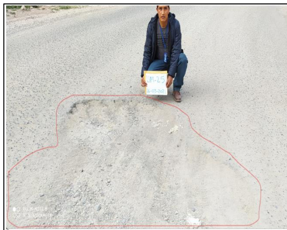
Figura 8. Aplicación de vuelo a 50m e identificación de hueco de severidad media
