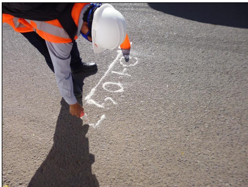
EVALUACIÓN DE FALLA POLIMIENTO DE AGREGADOS
