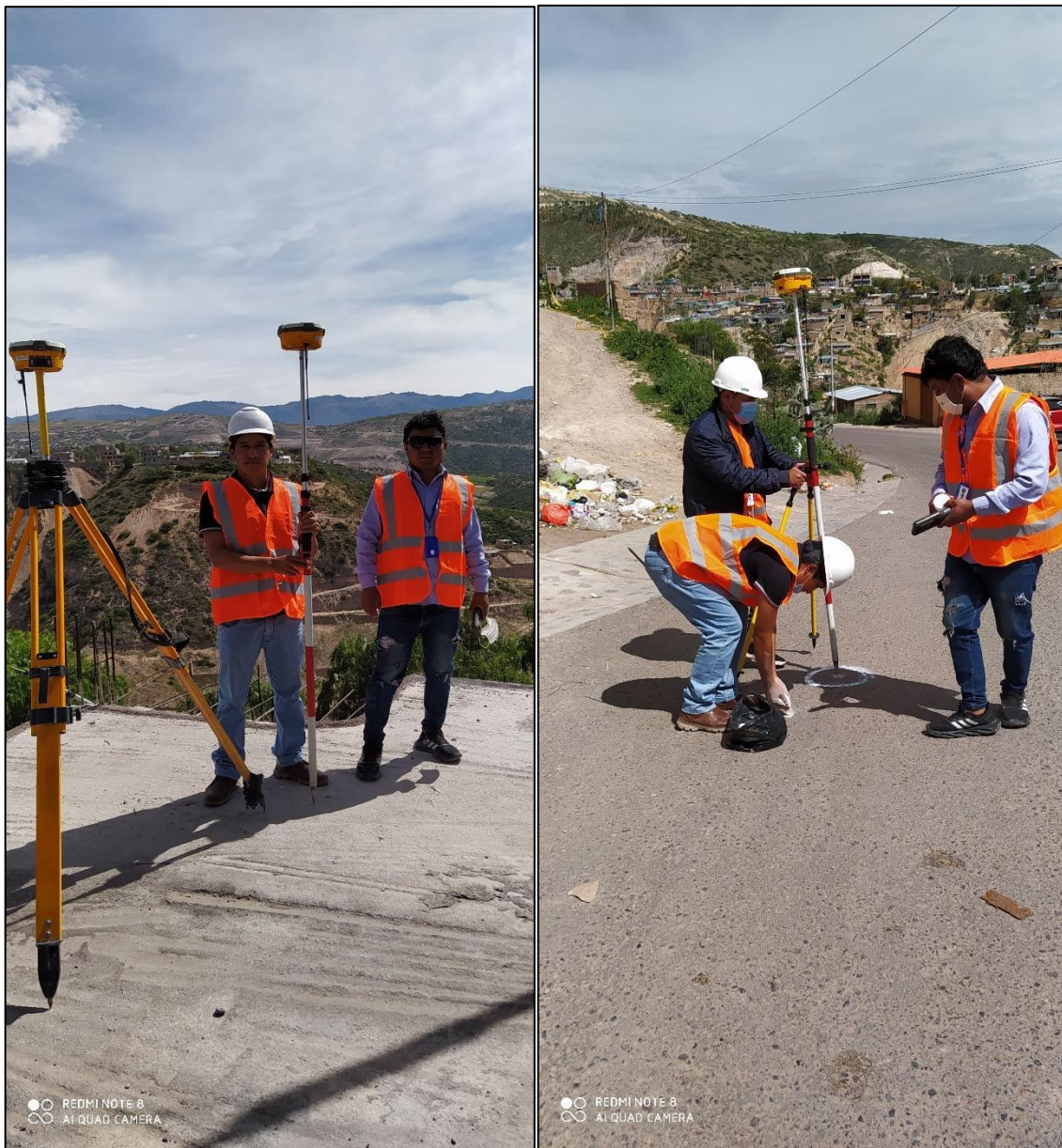
COLOCACION DE PUNTOS DE CONTROL
