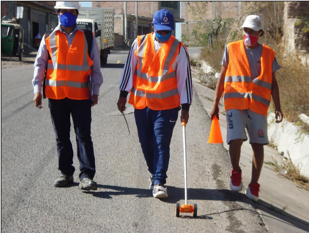
Figura 9. Determinación de longitud de cada unidad de muestra con odómetro
